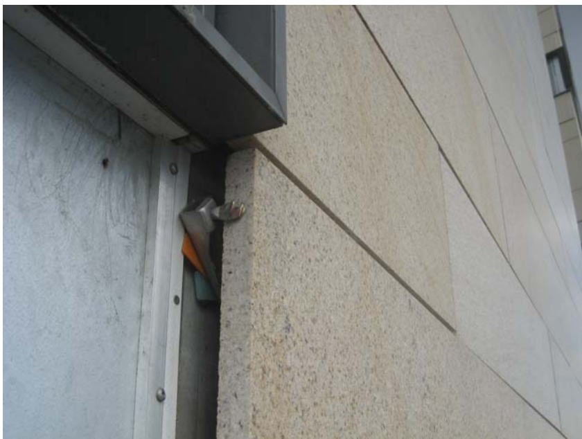
Foto. 4, 30 mm granitplader opsat med dorn på et holdeanker i vertikalfuge.
