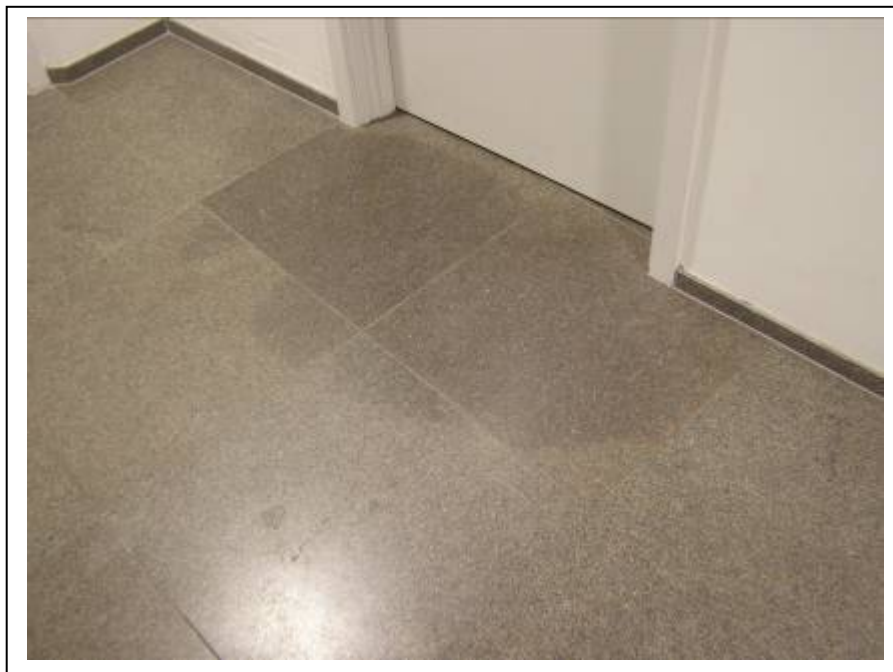
Figur 3.1: Eksempel på naturstensgulv (granit) med indesluttet fugt i underlaget
