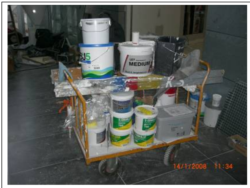
Figur 5.1: Ikke helt overraskende bruges der mange forskellige materialer og kemiske forbindelser i forbindelse med færdiggørelse af et byggeri. I dette tilfælde er det nylagte gulv ikke beskyttet overfor evt. spild af væsker eller stoffer af den type, som f.eks. står på vognen
