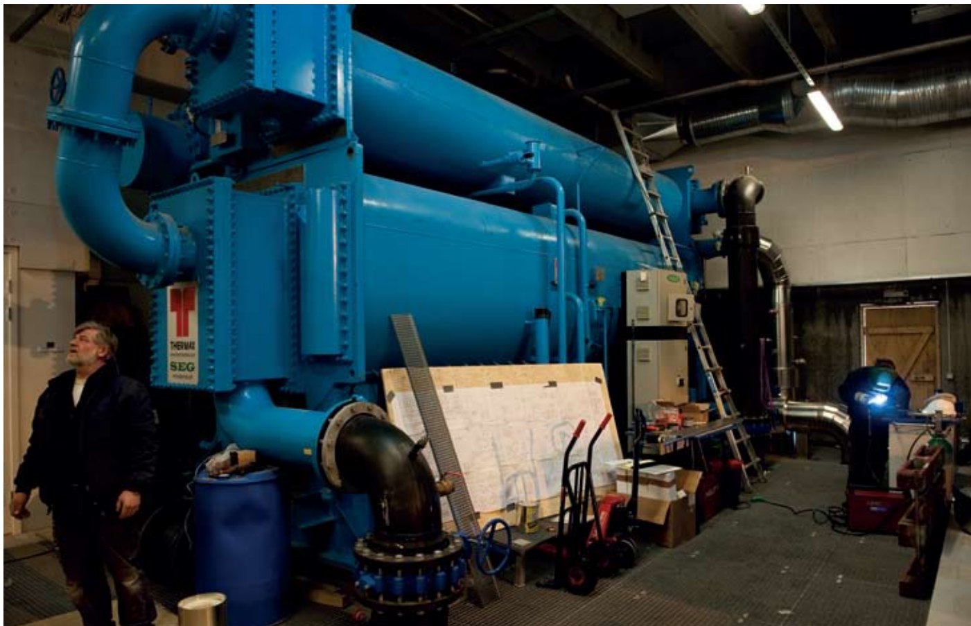
Absorptionskølemaskinen som drives af overskudsvarme fra affaldsforbrændingen og kraftvarmeværkerne.
