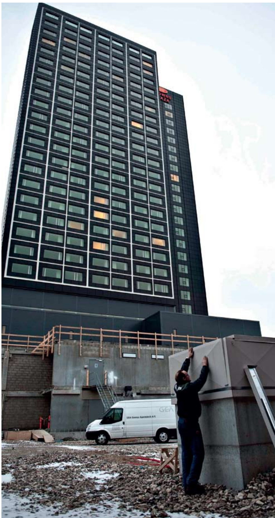
Jens Junggren foran åbningen til den ene af brøndene. Den bliver senere dækket af en bygning, når Copenhagen Towers udvides.
