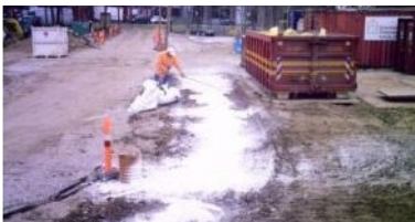
Udlægning af kalk
