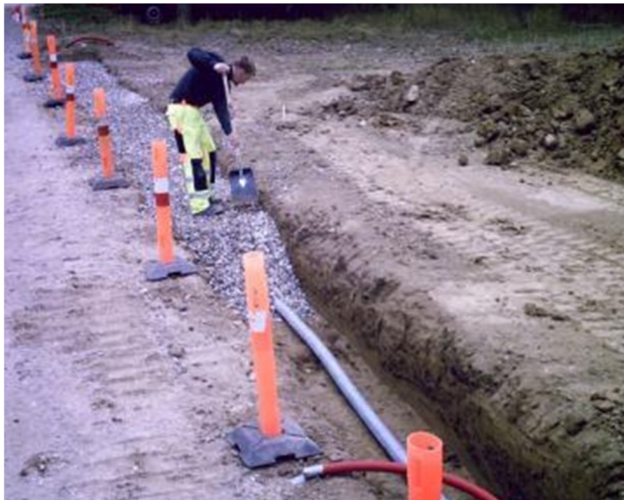
Grøften fyldes med singles, bemærk desuden det nedlagte trækrør.
