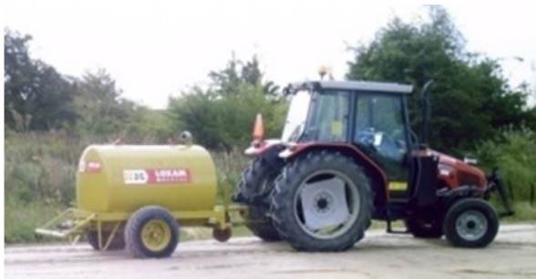
Vanding af udlagte materialer med vandspreder.
