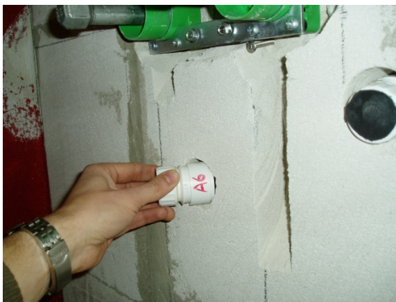
Figur 13. Placering af sensorer i letbetonvægge. Sensorerne omsluttet efterfølgende med mørtel og derefter lægges membran og opsættes fliser.
