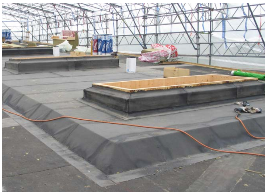
Figur 40. Opbygning af varmtag.
