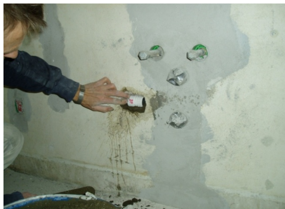
Figur14. Placering af sensor i kalksandstensvæg.
