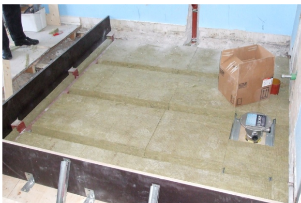
Figur 37. Baderum forberedt til støbning af betonplade i gulv.
