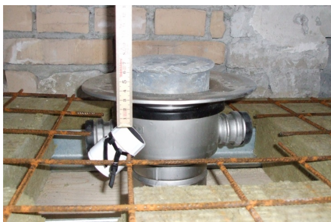
Figur 38. Sensor placeret i umiddelbart nærhed af et afløb i gulv i baderum.
