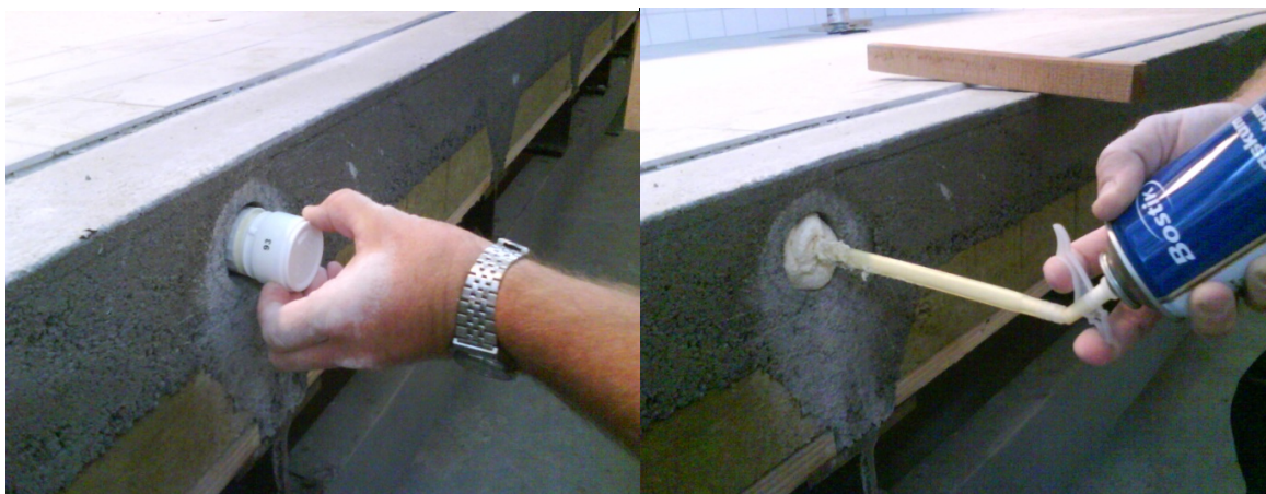
Figur 24. Montering af ny sensor i betonplade i etagedæk og forsegling med formskum.
