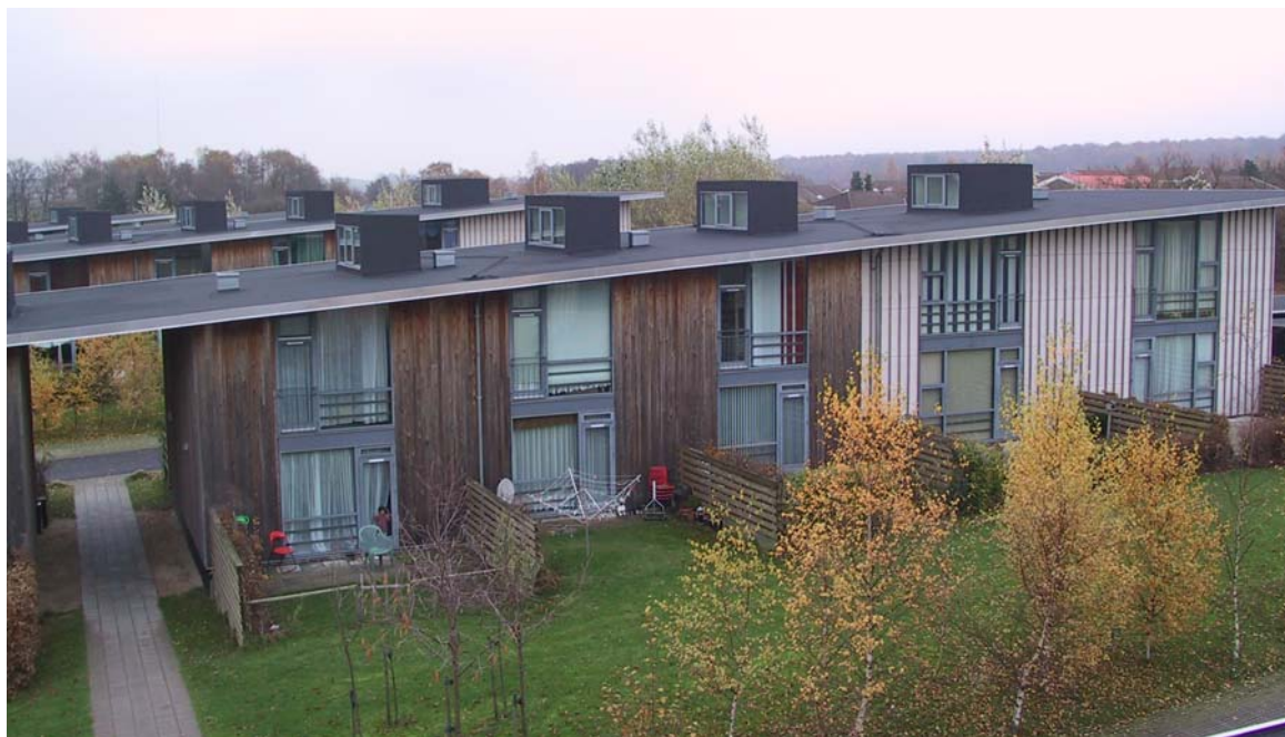
Figur 33. Bebyggelsen før renoveringen.
