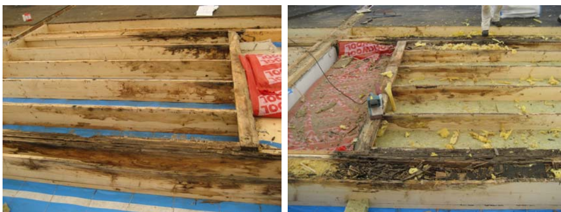
Figur 34. Råd- og svampeskader i tagkassetter.
