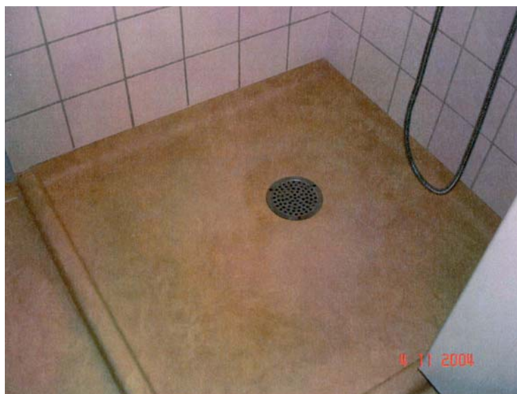
Figur 41. Gulv i bruseniche før hultagning.
