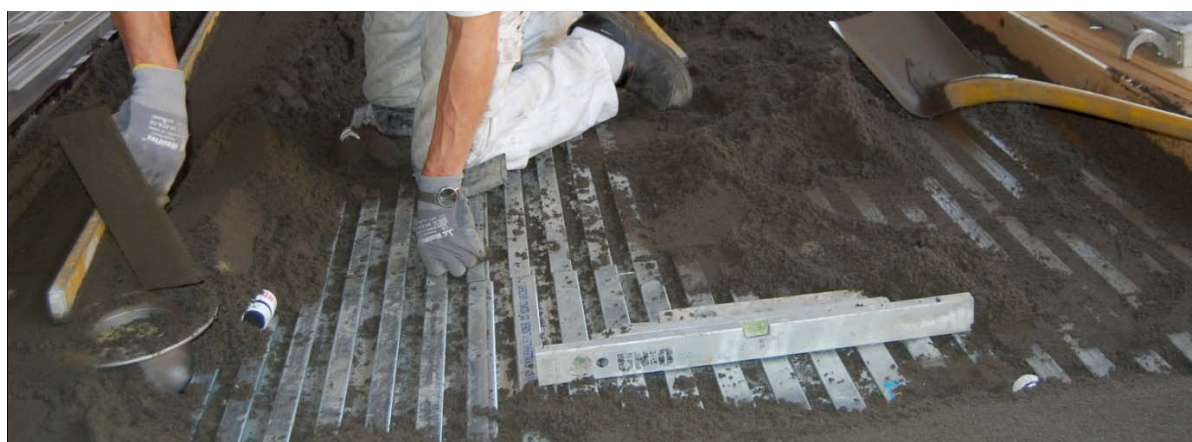
Figur 20. Indstøbning af sensor i betongulvet med svalehaleprofileret stålplade lagt som underlag for betonpladen.
