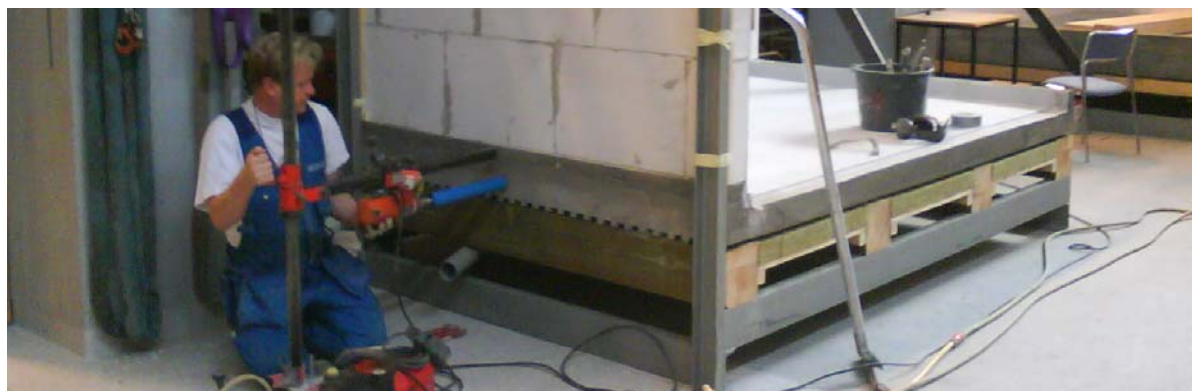
Figur 23. Boring af hul til montering af ny sensor i betonplade i gulvkonstruktion.
