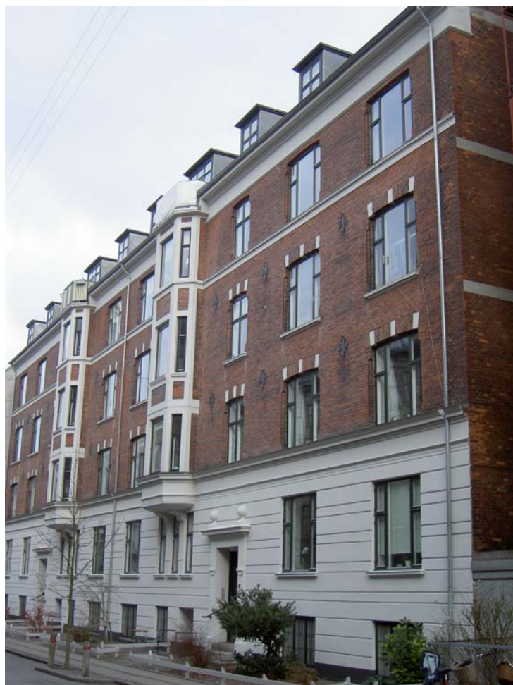
Figur 35. Ejendom i København, facade mod gade. Gavlen er frilagt.
