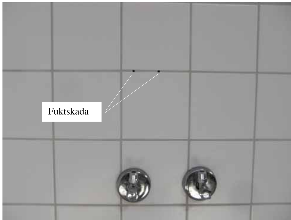
Figur 9: Fabricerad fuktskada ovanför duschinfästningen på den vänstra badrumsmockupen
