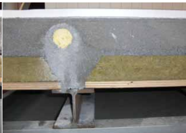
Figur 7: Den högra mockupens golvkonstruktion
