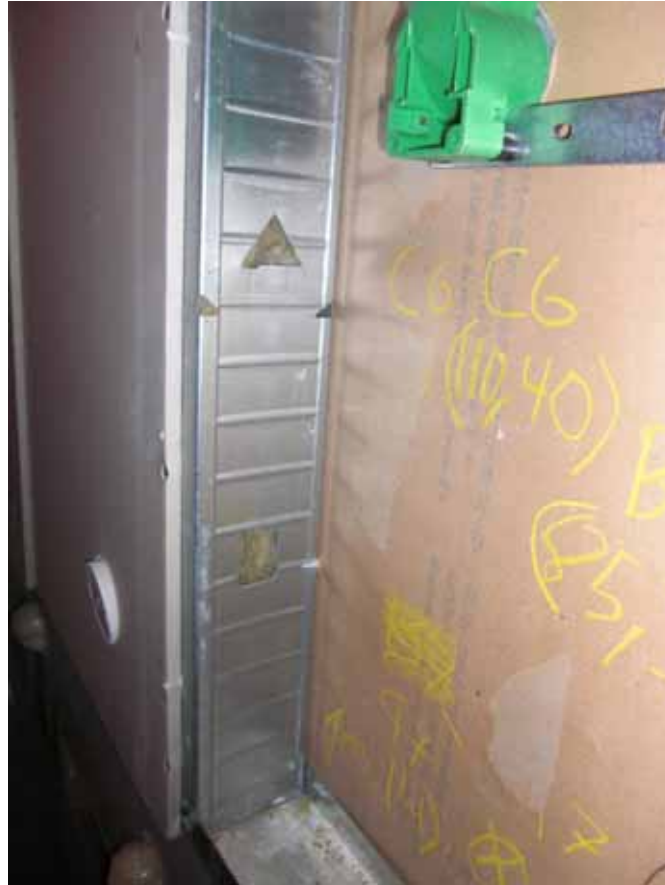
Figur 12: Håligheter i stålregelvagg där fukt kan passera
