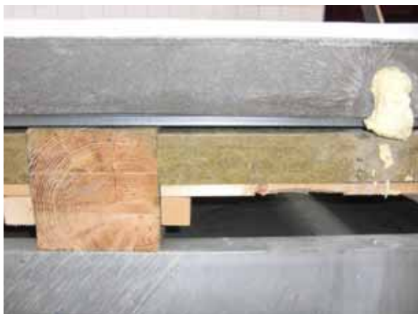
Figur 6: Den vänstra mockupens golvkonstruktion
