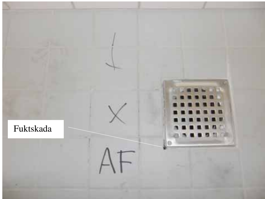
Figur 10: Fabricerad fuktskada intill golvbrunnen på den högra badrumsmockupen
