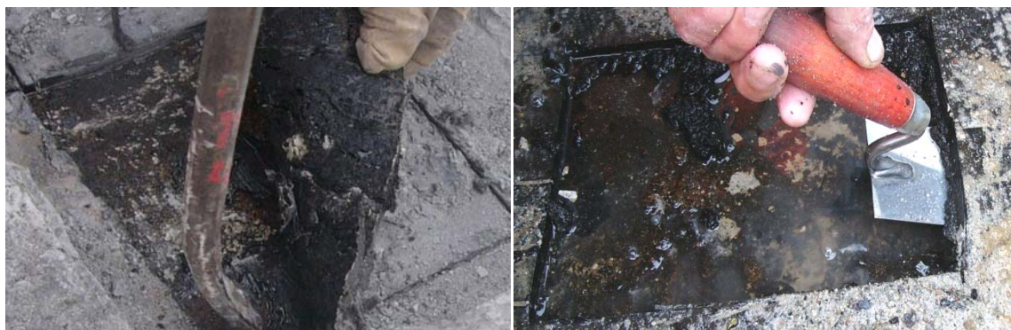
Figur 1. Foto til venstre, normalt område, betonoverfladen er tør og fugtisoleringen har fuld vedhæftning. Foto til højre, meget skadet område: frit vand under fugtisoleringen, og fugtisoleringen hæfter ikke.
