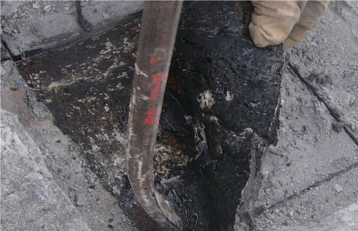
Foto 1, normalt område, betonoverfladen er tør og fugtisoleringen har fuld vedhæftning
