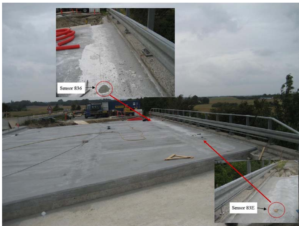
Figur 11. Placering af sensorer på nordbro i vestgående retning, ved Holbæk på Holbækmotorvejen.
