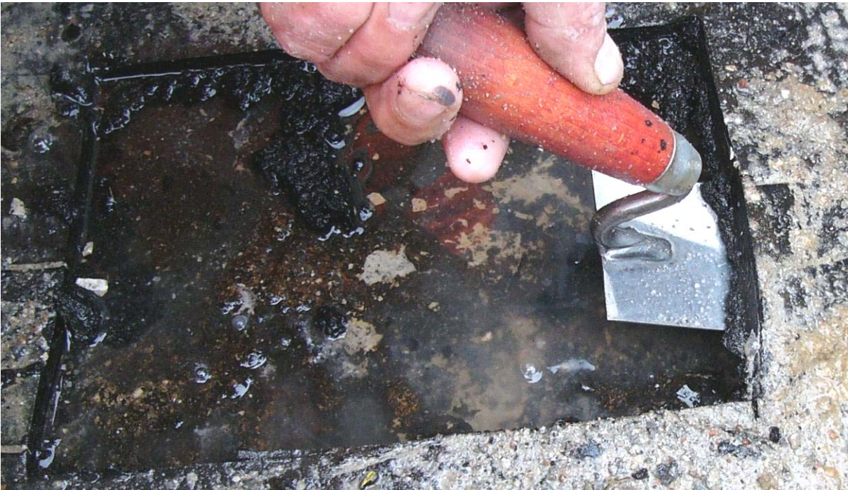
Foto 2, meget skadet område: frit vand under fugtisoleringen, og fugtisoleringen hæfter ikke
