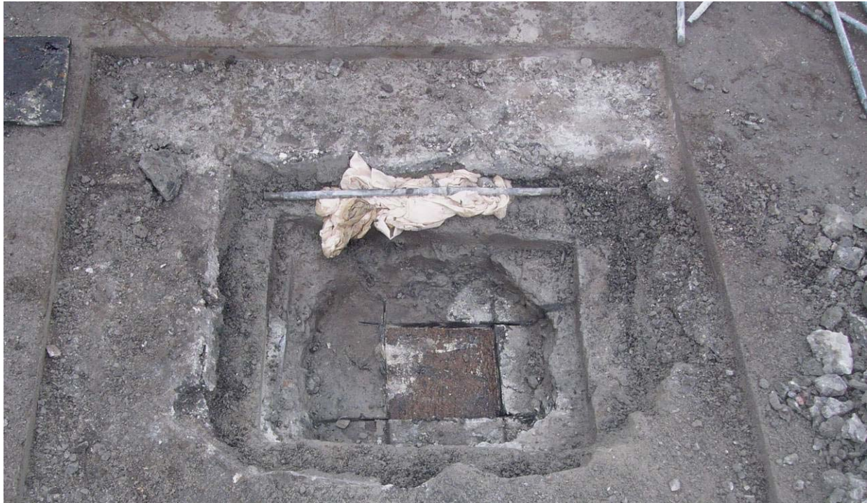
Foto 3, gammel beskyttelse af fugtisolering: 2 lag asfalt og 1 lag armeret beskyttelsesbeton.
