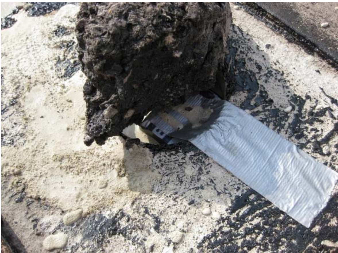
Figur 19. Fotos af installation af sensorer på Borrevejle Vig pæledæk. Sensor holdes fast af gaffatape i borehullet og asfaltklumpen bruges til at holde sensoren nede i reparationsmørtelen imens den hærdet af.
