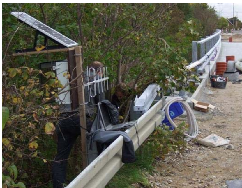
Figur 5. Transmitterboks (forgrunden) med antenne pegende mod brodæk
