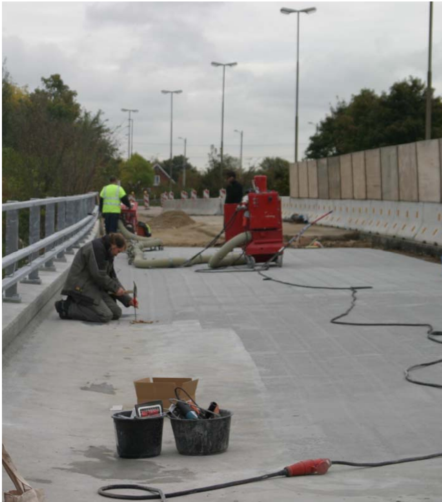
Figur 2. Reparation af brodæk. Halvdelen af brodækket er afspærret imens den repareres.
