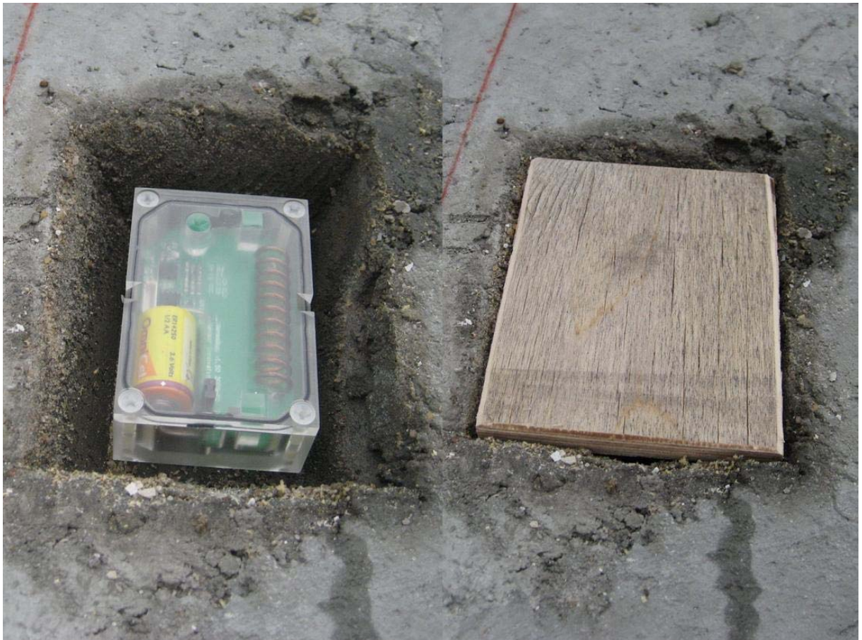
Figur 18. Fotos af installation af sensorer på Holbæk motorvejen.
