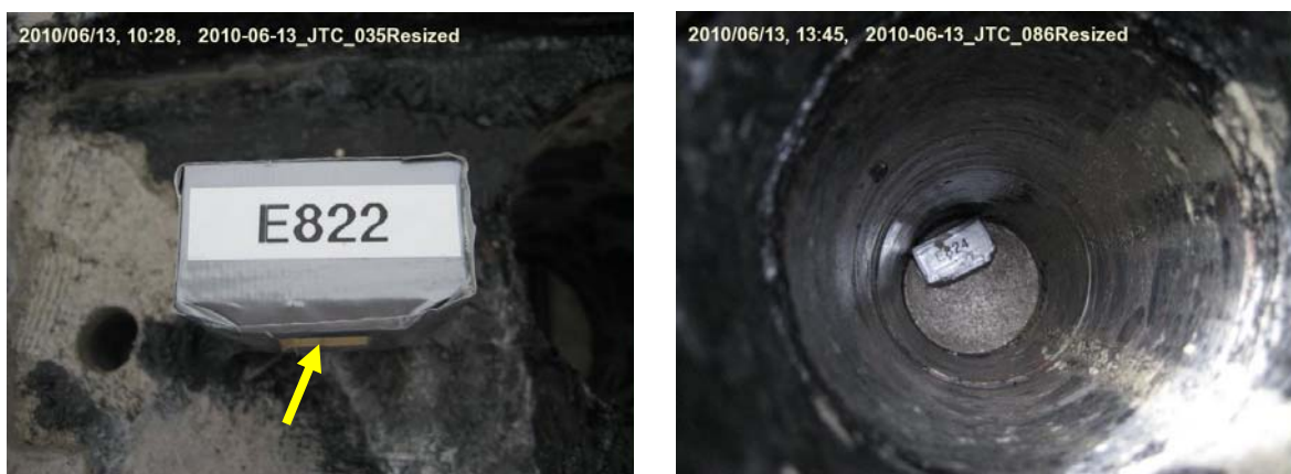
Figur 20. Foto til venstre af indpakket sensor installeret på Fiskebækbroerne. Træpladen der beskytter hullet til fugtregistreringer kan anes på undersiden af sensoren. Foto til højre viser sensor placeret i boret hul i oversiden af travers.
