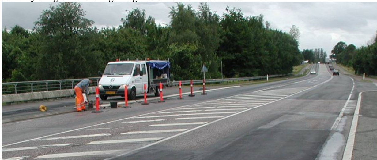
Foto 4, Ved stilstand på vejen skal der søges tilladelse og afspærring skal etableres.
