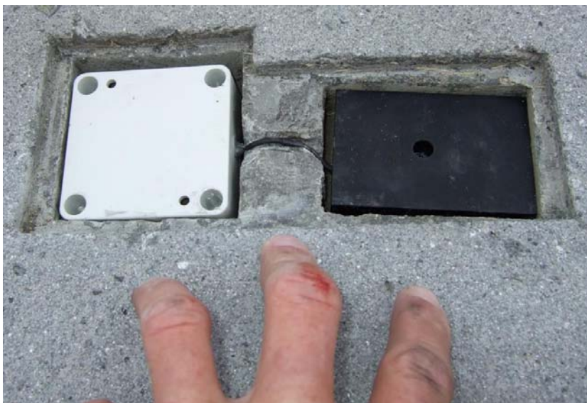
Figur 3. Batteri (venstre) og sensor (højre) placeret i udsparring
