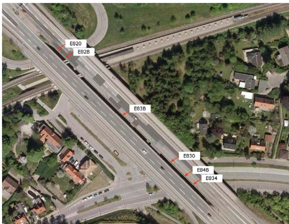
Figur 9. Placering af sensorer på østbro, ved Skovdiget på Hillerødsmotorvejen.
