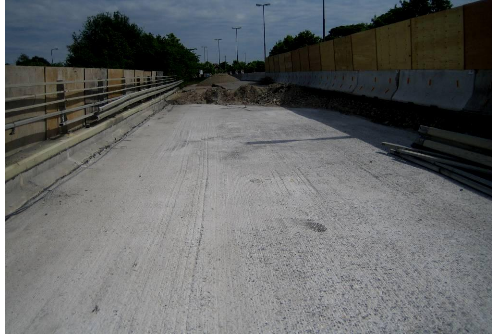
Efter fjernelse af membran: Ingen tydelige utætheder i membran
