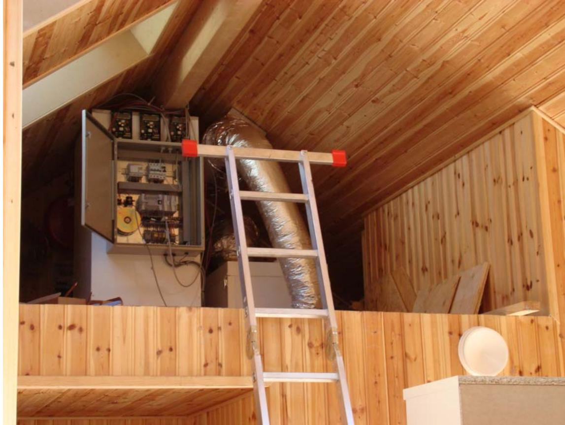
Forvarmet luft fra taget ledes til varmt vands beholder via varmepumpen der er placeret i teknikrum tæt på taget ligesom i SOLTAG projektet.
