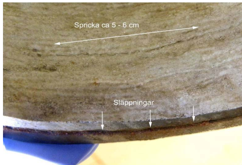
Figur 7 Spricka i omkretsriktning med en längd på ca 5 – 6 cm. Det fanns sprickor som var genomgående
