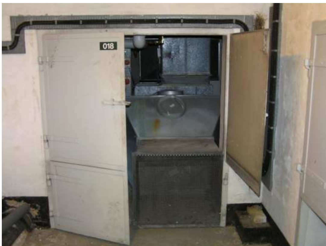
Billedet viser et af flere decentrale indblæsningskamre i luftfordelingsrummet, i gammel litteratur kaldt varmekamre.
