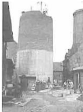
Den murede skorstens bevndelse
