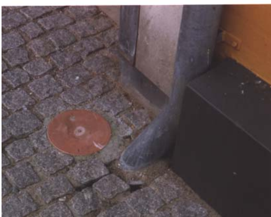
Figur 3.6 Eksempel på afdækning med dæksel af PP
