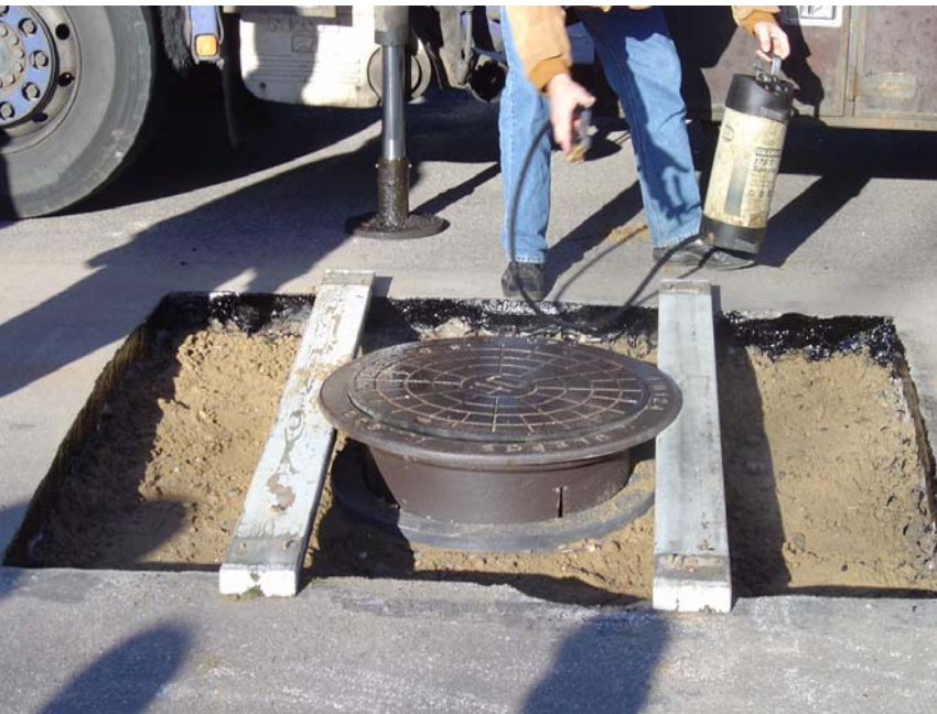
Overside af karm og dæksel smøres med slipmiddel.
