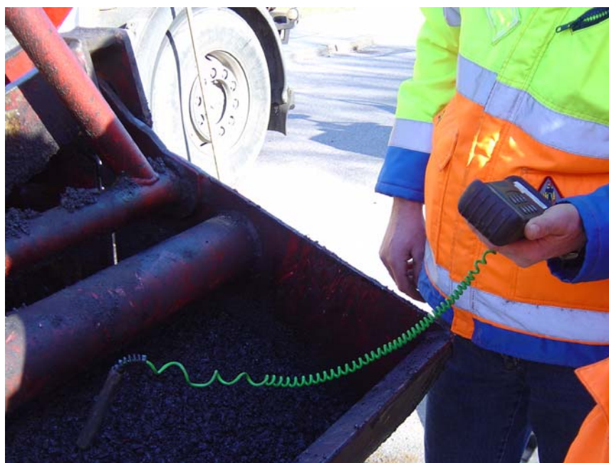
Asfalttemperaturen kontrolleres inden brug.
