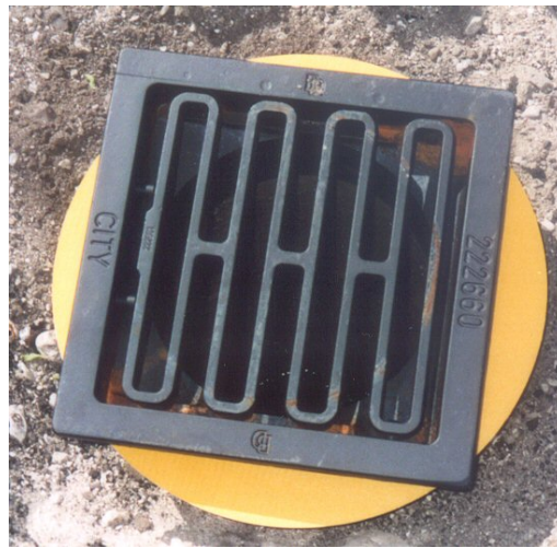
Figur 8.2 Eksempel på pakning af pap på nedløbsbrønd
