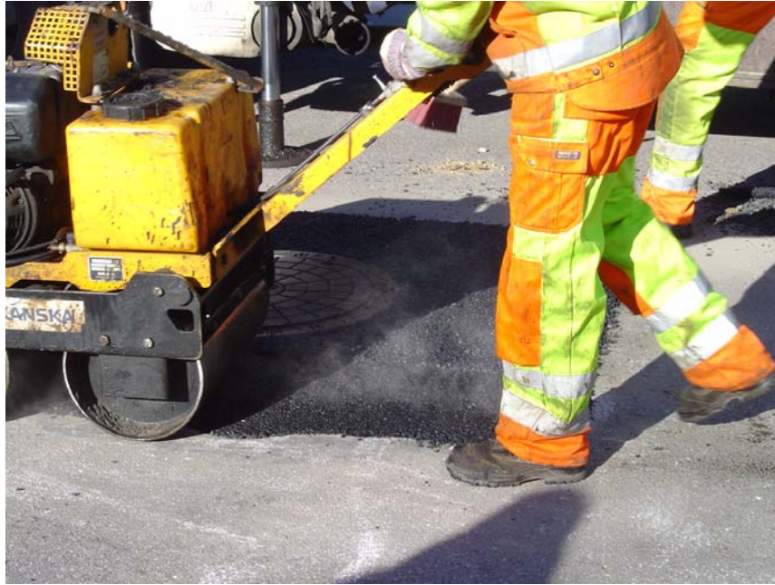
Asfalten omkring brønden komprimeres med tromle.
