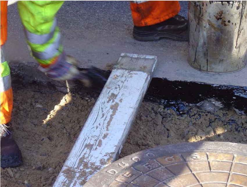
Der smøres emulsion på den opskårne asfalt.
