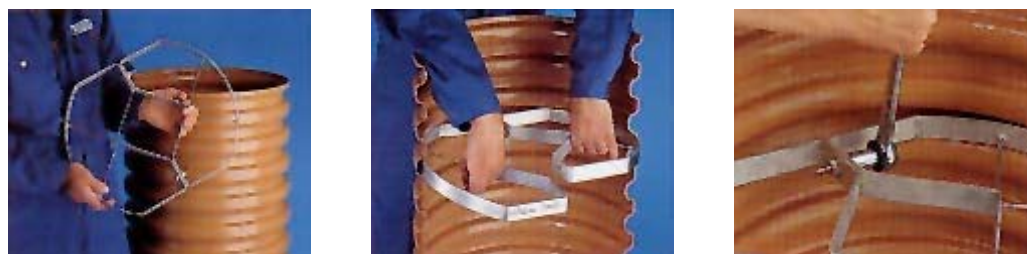
Figur 5.2 Billede af sikkerhedsindsats i korrugeret plastrør
