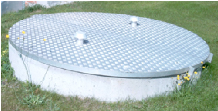
Figur 3.5 Eksempel på afdækning af aluminium
