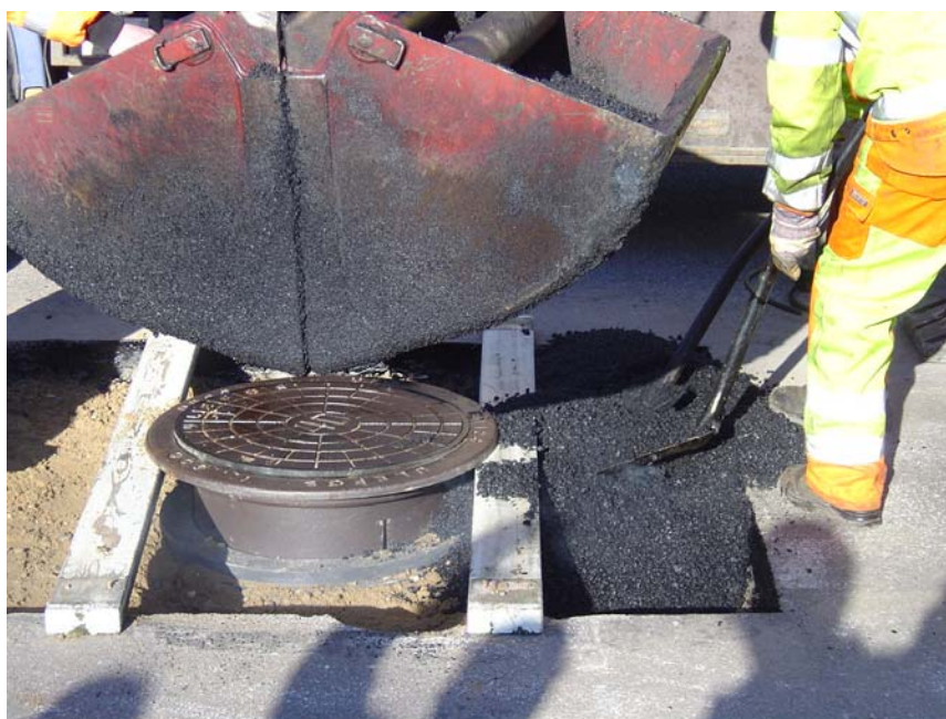
Asfaltmaterialet fyldes i og komprimeres omhyggeligt for hver 100 mm. Opfyldningen slutter, når asfalten når op til karmens indvendige bæreflade.
