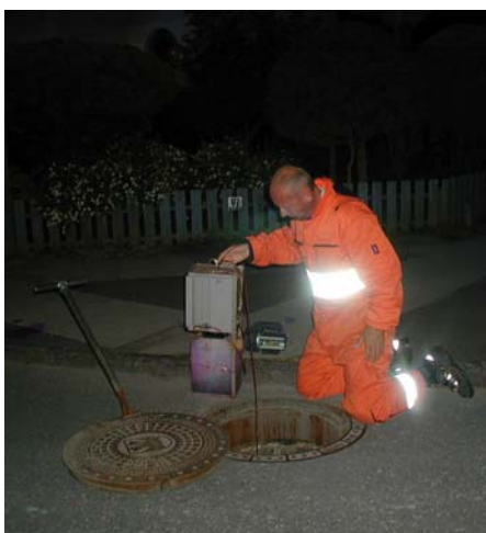
Figur 6.4 Doseringspumpe anbragt i en brønd (Krüger A/S)
