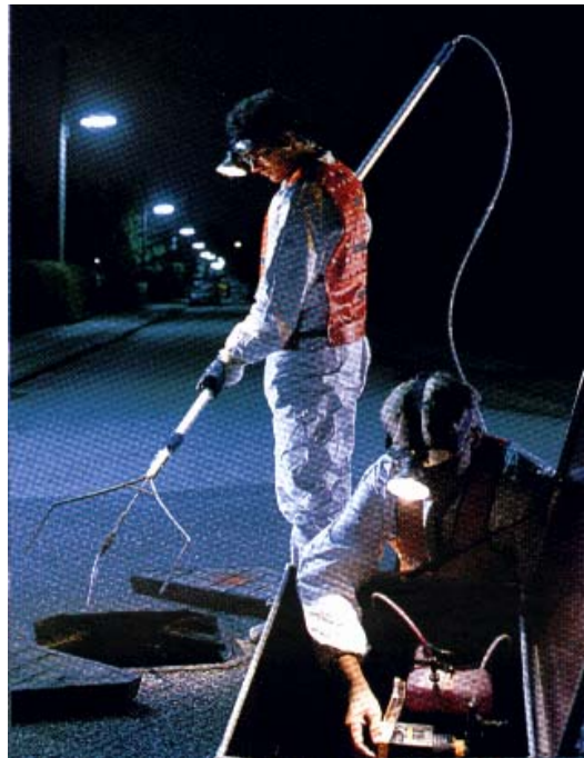
Figur 6.5 Udtagning af prøver, der analyseres for sporstof (Krüger A/S)
