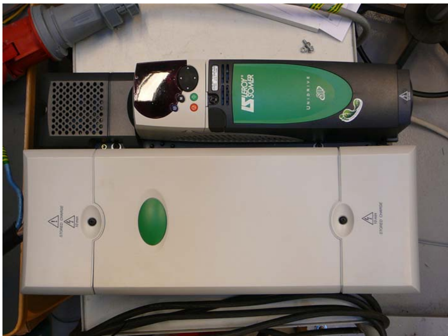
Figur 3.15. Frekvensomformer til 19,2 kW PM motor.
