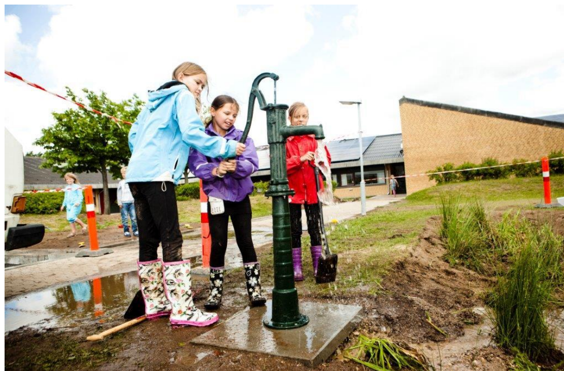
Figur 2: Collectio er en faskine med membran under bunden og 1/3 op ad siderne, så der er et underjordisk vandbassin. Vandet kan efter behov pumpes op. Her pumpes regnvandet til regnbedet på klimaskolen i Roskilde (foto: Thomas Wilhelm, SpecialPhoto).
