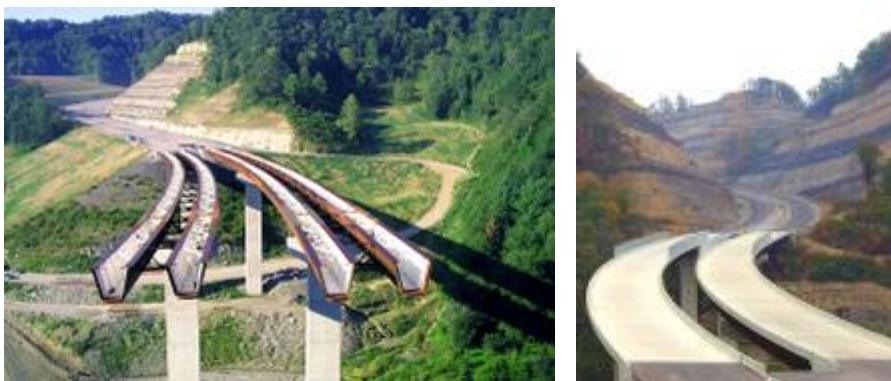
Figur 2.1-4 Raccoon Creek Bridge Tv: Broen under opførelse Th: Den færdige konstruktion.
