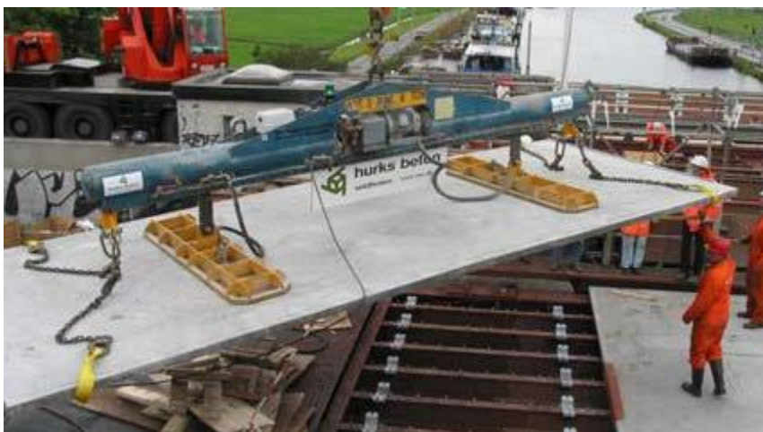
Figur 2.2-3: Ultratyndt dækpanel i CRC højstyrkebeton løftes på plads på den ene af Kaag-broerne.
