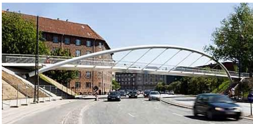
Figur 2.1-1 Ågade Stibro – slank konstruktion i stål.
