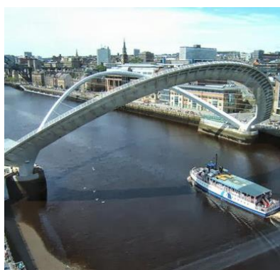
Figur 2.1-5 Gateshead Millenium Bridge: Tv: "Lukket bro" med adgang for cyklister og fodgængere. Th: "Åben bro" med øget frihøjde til den sejlsende trafik under broen.
