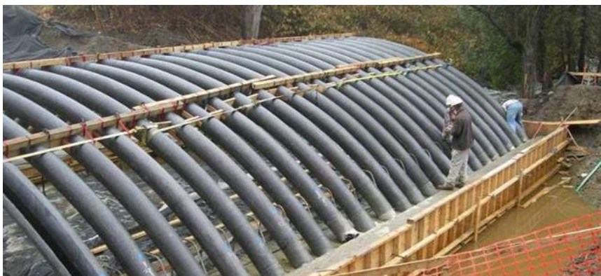
Figur 2.4-1 Kulfiberslanger placeres på fundamentet.
