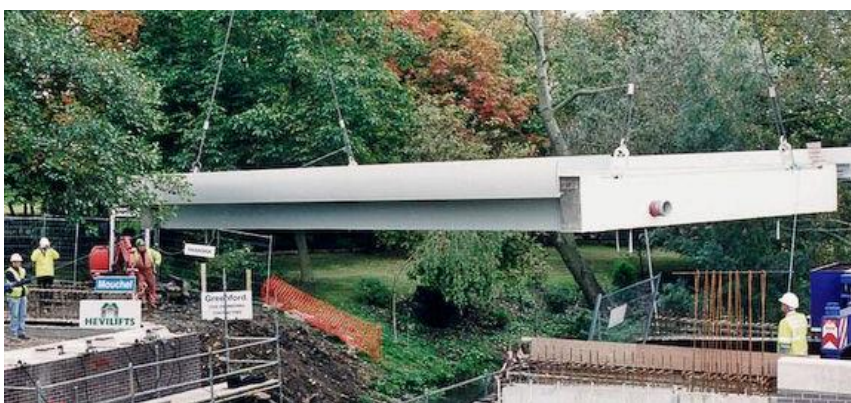
Figur 2.3-4 Det første produkt af ASSET-projektet: West Mill Bridge, Oxfordshire.
