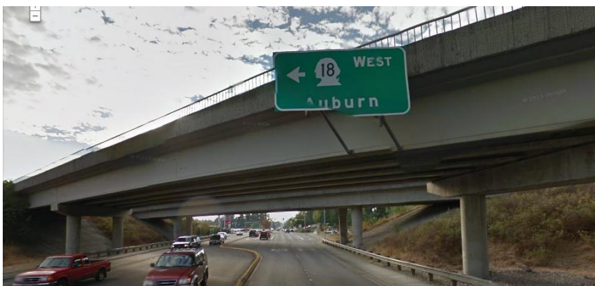
Figur 2.2-2: Demonstrationsprojekt med motorvejsbro "SR 18 over SR 516" i højstyrkebeton fra staten Washington.
