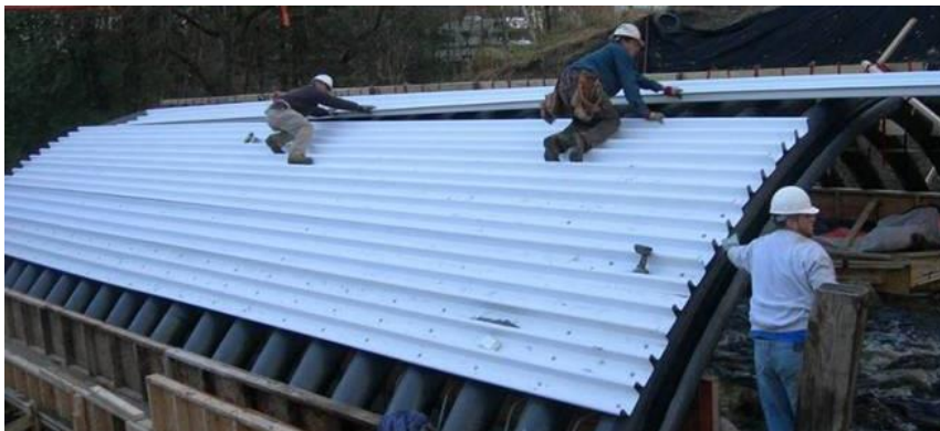
Figur 2.4-2 Skal af korrugeret plast lægges oven på rørene.
