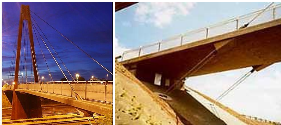
Figur 2.4-4 Skråtagsbro ved Herning med armering og kabelstag i kulfiber.
