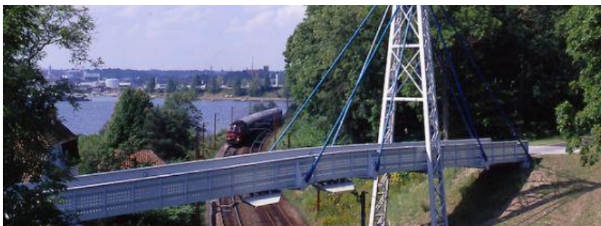
Figur 2.3-1 Stibro ved Kolding udført i plastbaseret komposit fra danske Fiberline.
