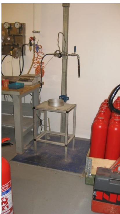
Figur 5. Vægt, hvor elektronikken ligger under kældergulv.
