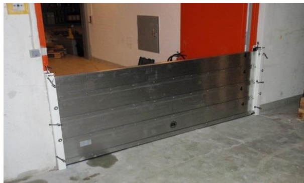
Figur 11. Til venstre porten ind til kælderen. Til højre beskyttelse af en indgang med et skot.
