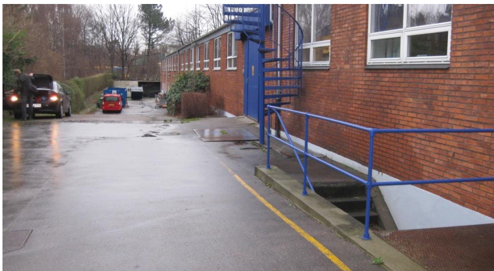
Figur 1. Terrænet falder kraftigt ned mod bygningens ende.
