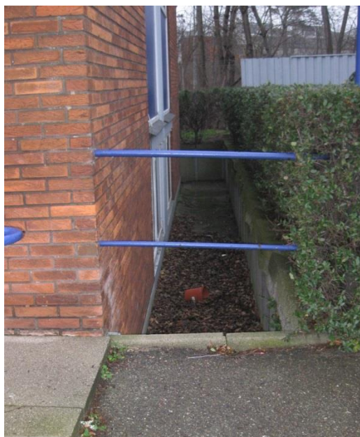
Figur 12. Kanten om lysgangen bør hæves.
