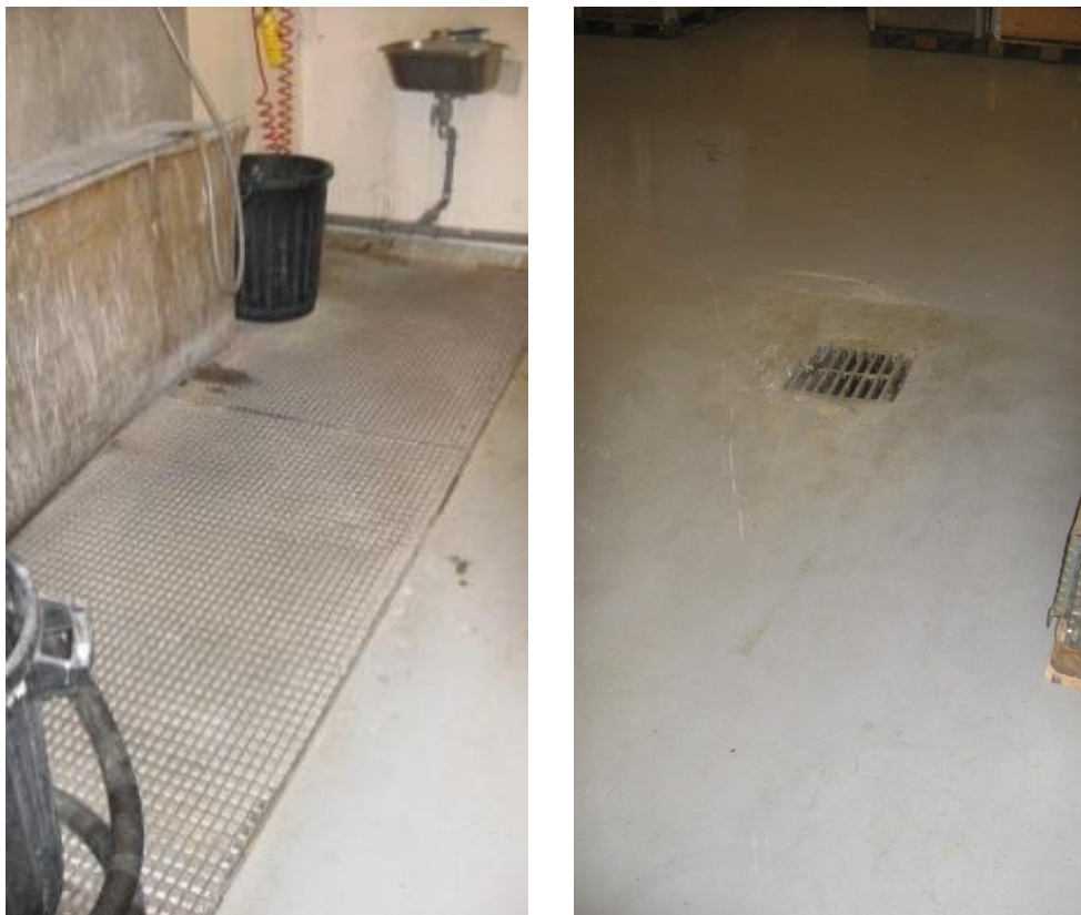
Figur 3. Nødvendige gulvafløb i kælderen er bevaret. De øvrige er fjernet.
