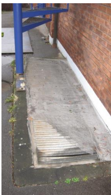
Figur 8. Kanten om lyskassen skal hæves eller lyskassen skal afblændes.
