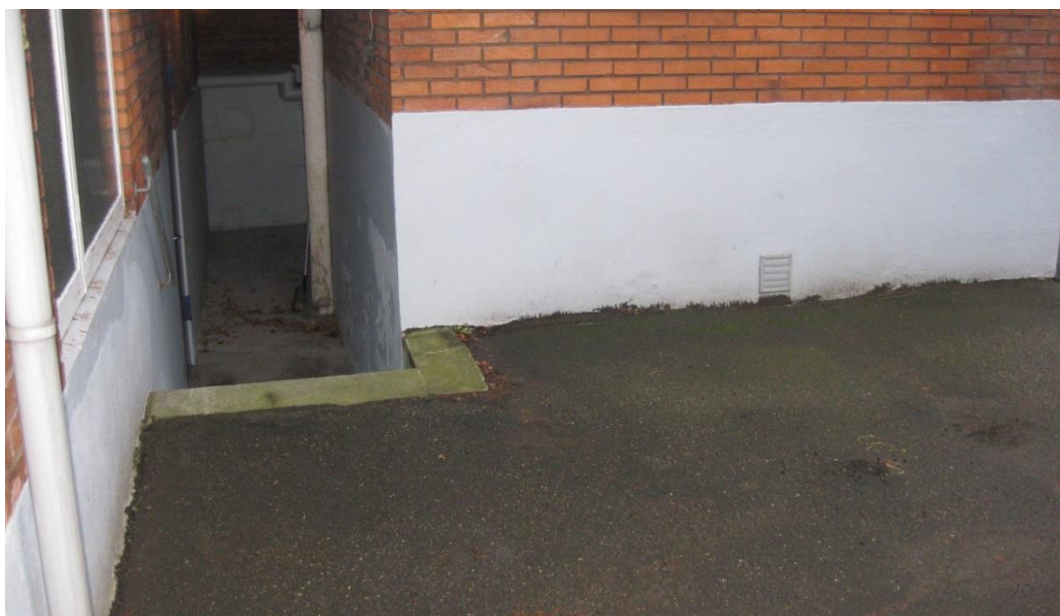
Figur 10. Kældernedgang uden opkant.
