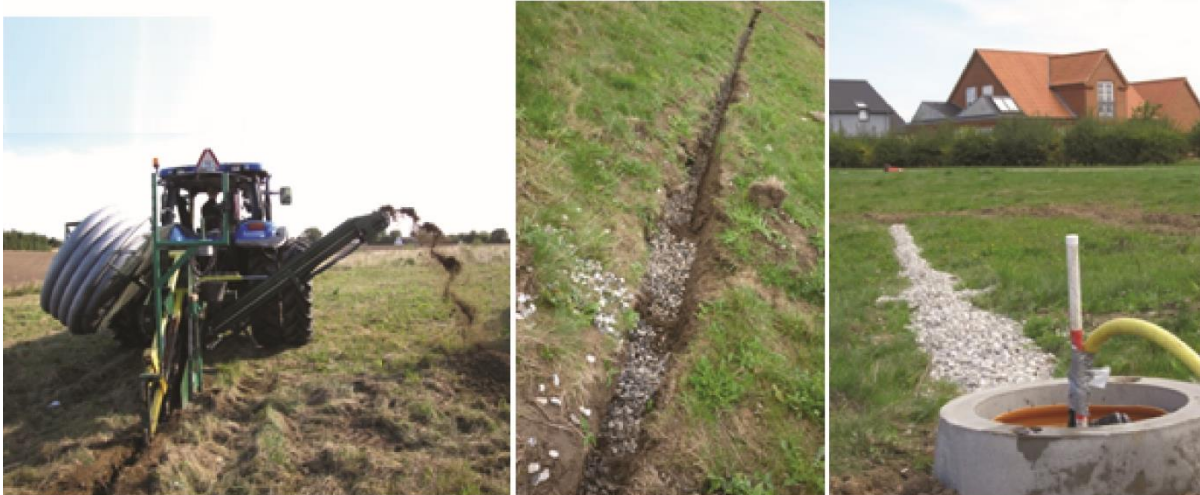
Figur 3: Implementering af terrænfaskine (dyb grusrende). Venstre: Frontmonteret kædegraver. Midt: Den delvist grusfyldte rende. Højre: Den færdige rende. 0.17 m bred, 15 m lang og 1 m dyb. Tilløbsbrønd ses forrest i billedet.
