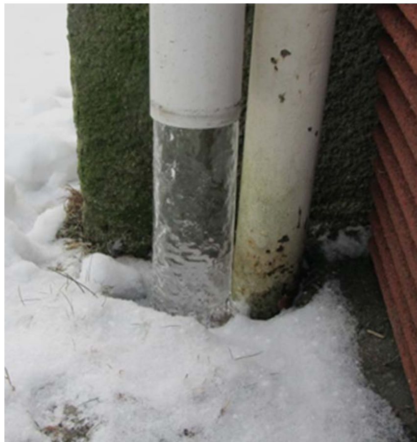
Detalj frikoblet taknedløp Tette flater rundt bygning, lite fall ut fra bygningskropp Foto: SINTEF Byggforsk
