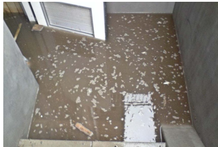
Tilbakeslag etter overbelastning av rørnett
