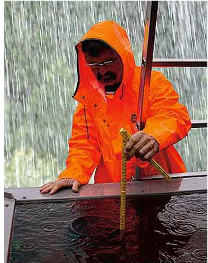
Ekstremnedbør og tette innvendige nedløp
