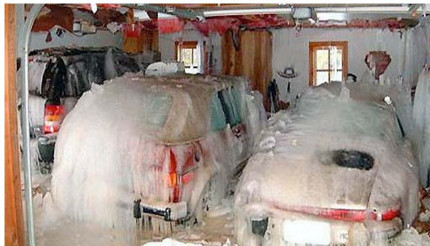
Frostsprengning av vannrør
