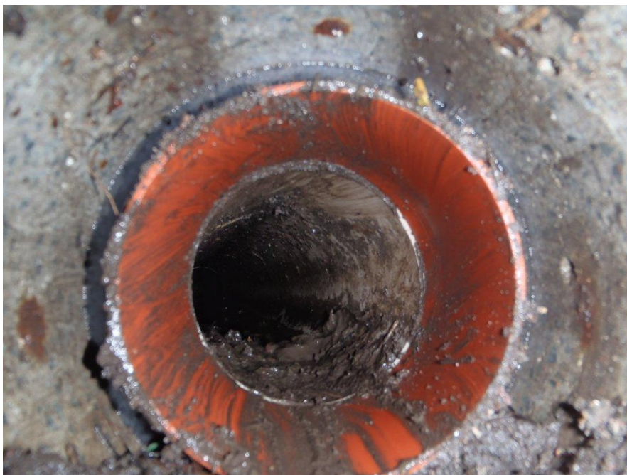
Foto 19: Tørlledning på tværs af vej ved det sydligste regnbed.
