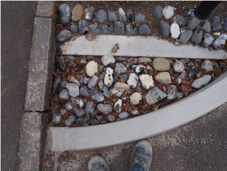
Foto 2: Indløb til nordligste vejbed.
