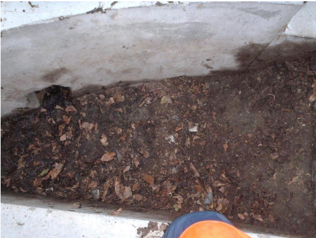
Foto 3: Indløb til nordligste vejbed efter fjernelse af sten. Drænhullet, der ses i bunden af betonkanten ind mod bedet, blev stoppet til i løbet af 2014, idet dræningen betød at vejvandet kunne løbe direkte til
