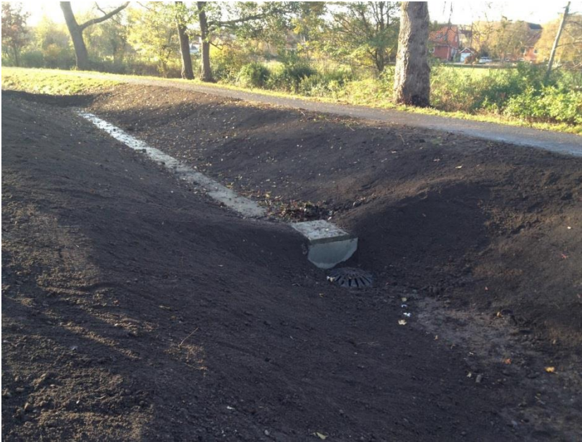
Foto 2: DPF i Krogebjergparken umiddelbart efter anlæg, og før vegetationen er genetableret. Forrest ses en del af forsinkelsesbassinet med tilhørende kuppelrist med før til indløbbrønd, og bagerst ses det 20 m lange forfilteret, der er afdækket med trælåg. Imellem bassin og forfilter er anlagt en lervold. Ved store regn kan volumen over forfilteret indgå som del af forsinkelsesbassinet, idet jordvolden da kan oversvømmes. Bagerst i billedet ses endnu en lervold, som danner overgang til hovedfilteret (underjordisk).
