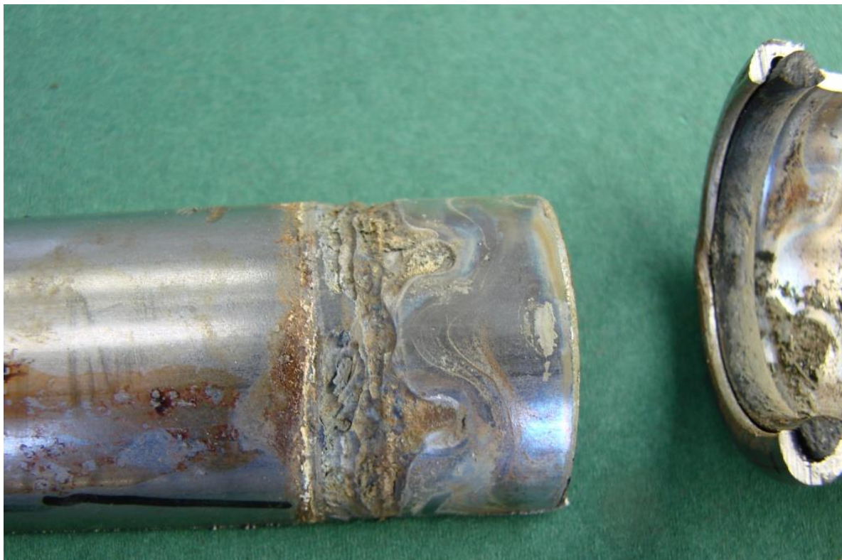
Dybt angreb på ydersiden af rør
