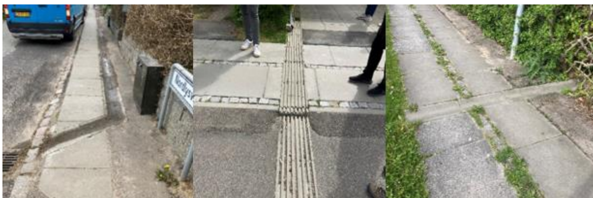
Figur 9: Udledning til rende i fortov (tv.), over både fortov og cykelsti (midt) samt til bassin over fortov (th.). Fotos: Teknologisk Institut.
