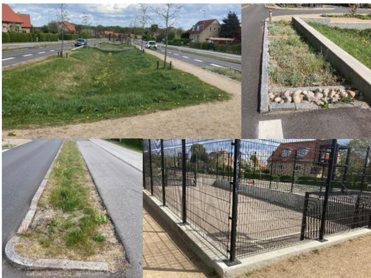
Figur 5: Risvang Allé. Øverst tv. regnvandsbassin i vejmidte, øverst th. vejbed; nederst tv. wadi og nederst th. boldbane/skybrudsbassin. Fotos: Teknologisk Institut.
