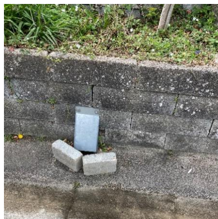
Figur 8: Anlæg hvor dræn pumpes ud i stikledningen der udmunder på overfladen. Foto: Teknologisk Institut.
