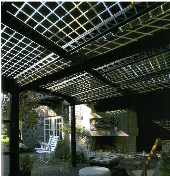
Semitransparente moduler i terrasseoverdækning.
