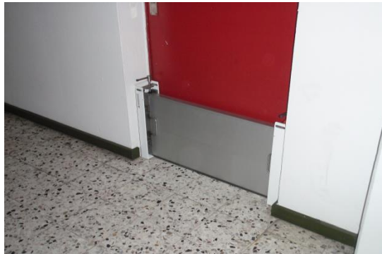
Figur 4.40 Eksempler på vandtæt dør ( www.siolit.com ) eller dør med vandtæt skot ( www.stormflodssikring.dk )
