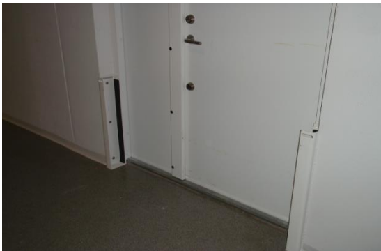
Figur 4.40 Eksempler på vandtæt dør ( www.siolit.com ) eller dør med vandtæt skot ( www.stormflodssikring.dk )
