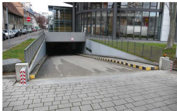
Figur 4.14 Linjedræn oven for en udvendig trappenedgang eller en garagedækørsel kan afskære tilstrømning af regnvand fra terræn
