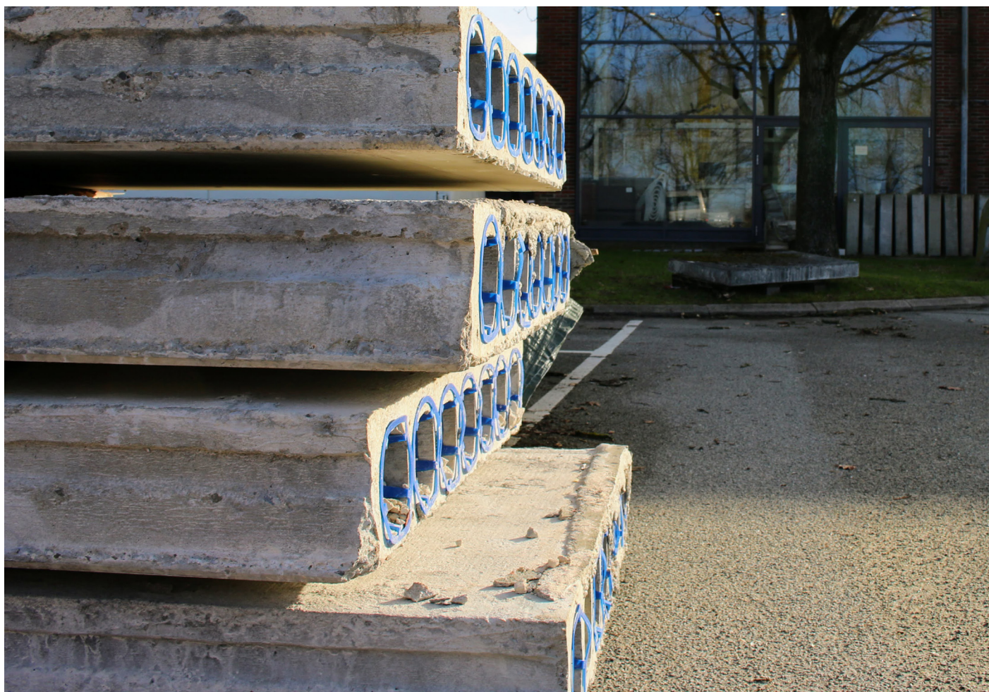
Fig. 02 Huldæk vurderes at være den mest anvendte betonelementtype i Danmark i dag, og anvendes til etageadskillelser og tagkonstruktioner. Huldæk skal i dag produceres i overensstemmelse med EN 1168. Foto: Teknologisk Institut
