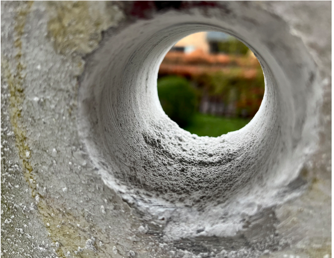
Fig. 12 Betonkonstruktion hvorfra der er udboret en betonkerne. Vand/cement-forholdet har stor betydning for betonens holdbarhed, f.eks. ift. karboniseringshastigheden. Vand/cement-forholdet kan estimeres på udborede kerner. Foto: Teknologisk Institut
