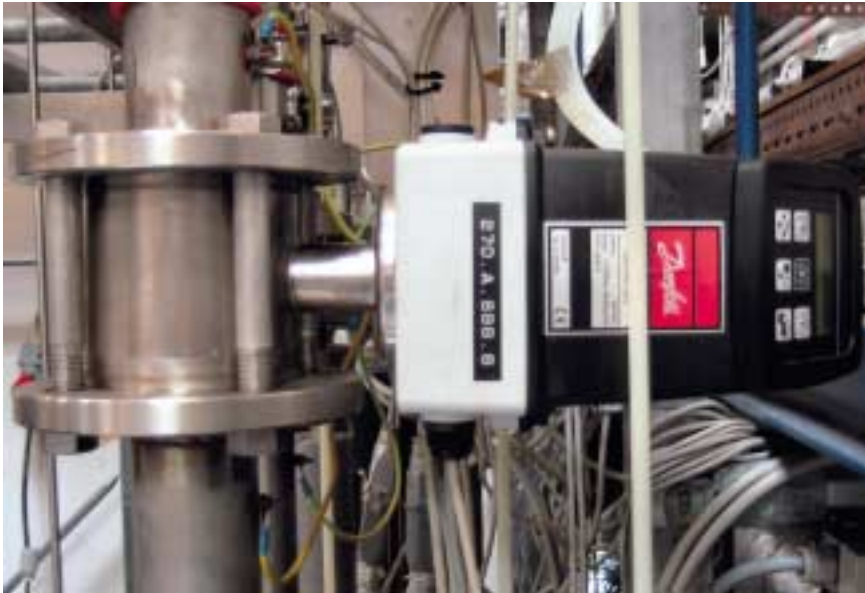
Hvor måles? Er målepunktet repræsentativt? Er alle instrumenter og kabler korrekt jordet?
