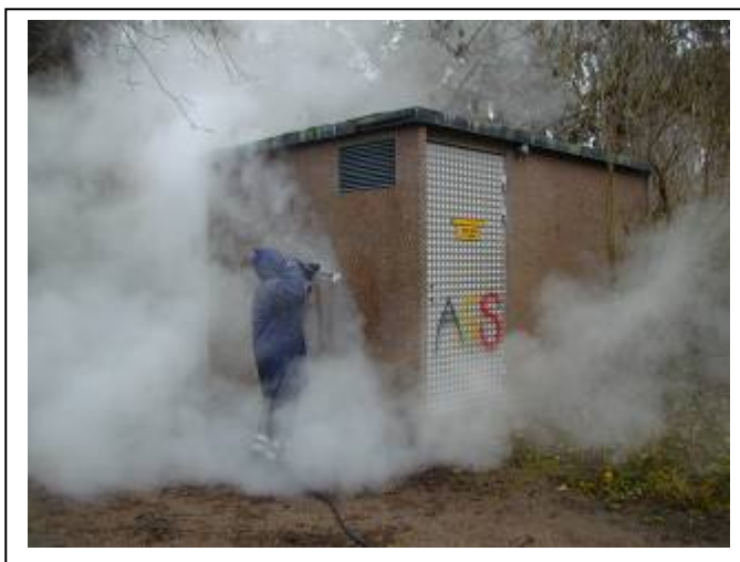
Figur 2.2: Hedvandsspuling for at fjerne resterne af graffiti og malingsfjerner.
