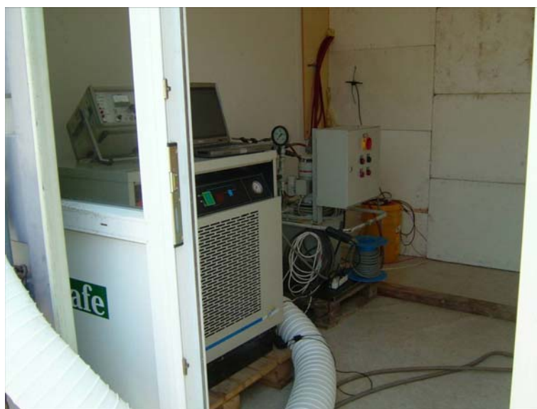
Hydraulik- og køleanlæg udvikler så meget varme, så temperaturen i dette rum kan blive op til 40 °C. Bagest ses den polystyrolvæg, der isolerer ind til prøveopstillingen.
