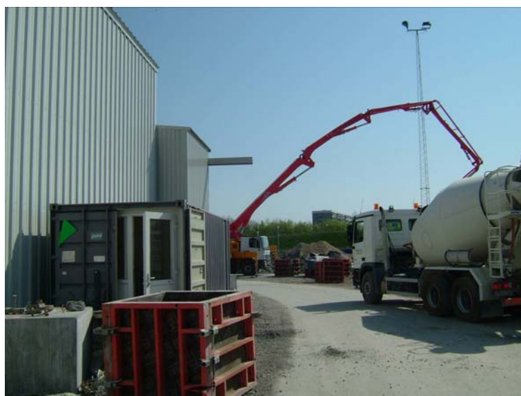
Det mobile laboratorium blev indrettet i en isoleret container
