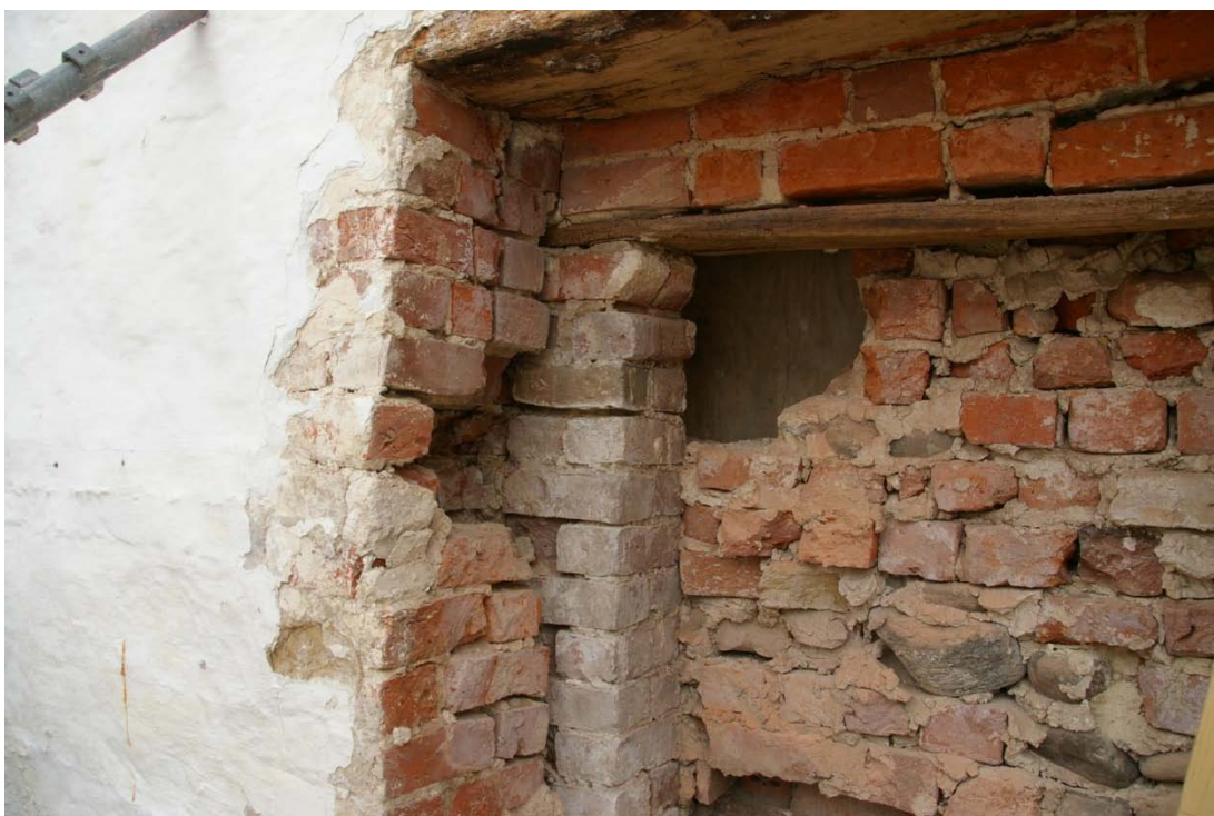
Fig. 6. Skib nordvæg. Prøve E, muremørtel dørfals
