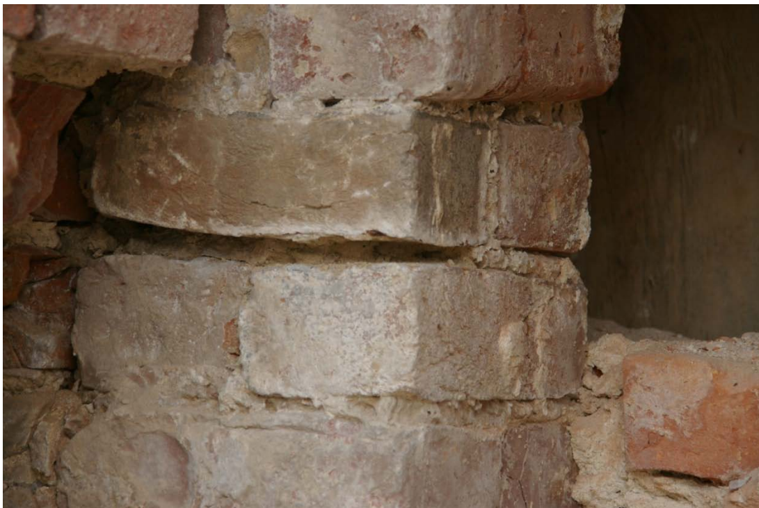
Fig. 7. Skib nordvæg. Prøve E, muremørtel dørfals
