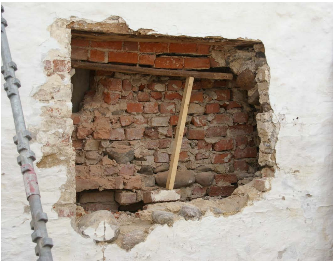
Fig. 5. Skib nordvæg. Prøve D, muremørtel lukkemur
