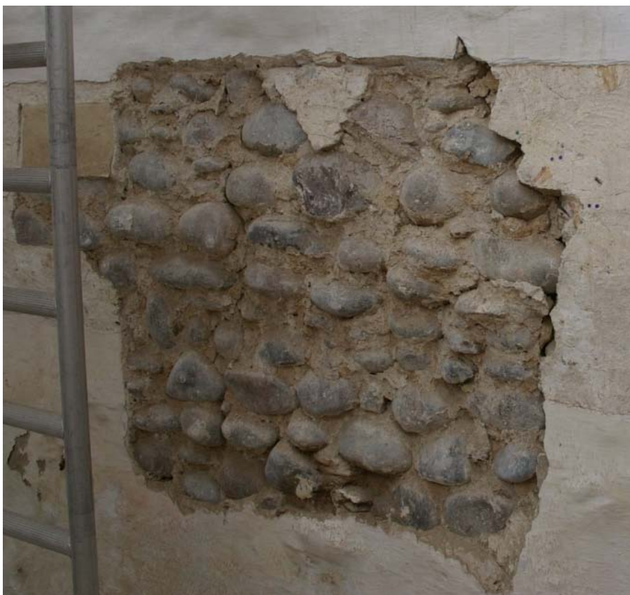
Fig. 2. Kor nordvæg. Prøve B, muremørtel
