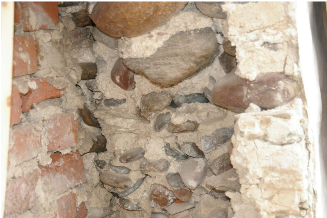
Fig. 4. Skib nordvæg. Prøve C, muremørtel indermur
