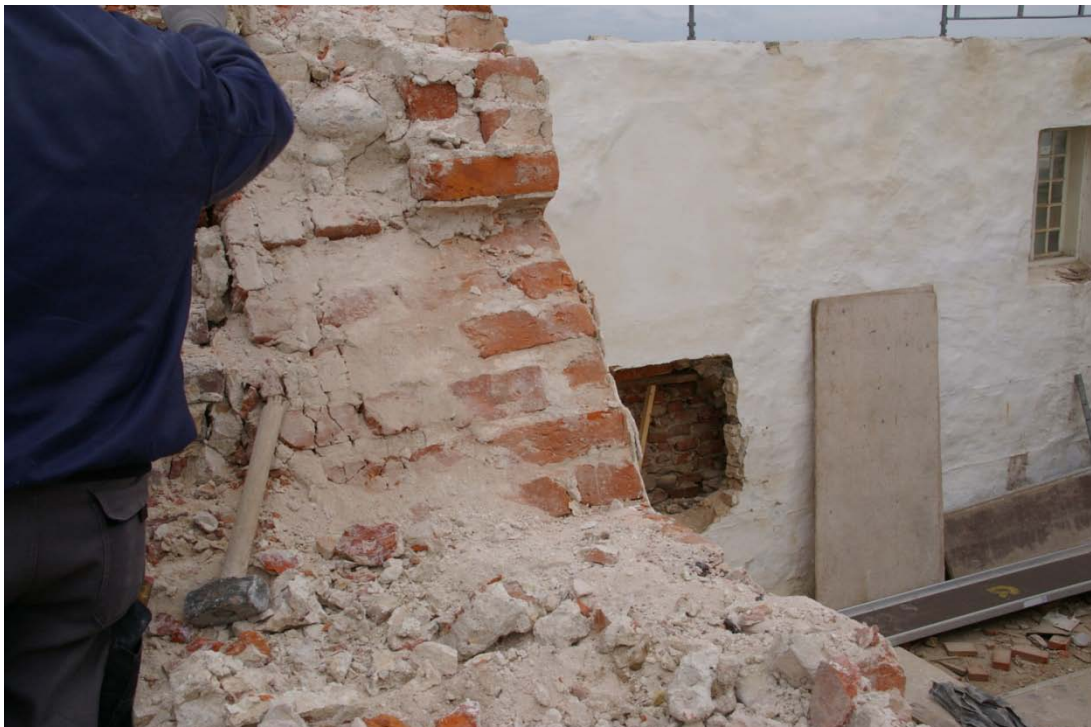
Fig. 8. Skib vestmur. Prøve F, muremørtel over tårnbue
