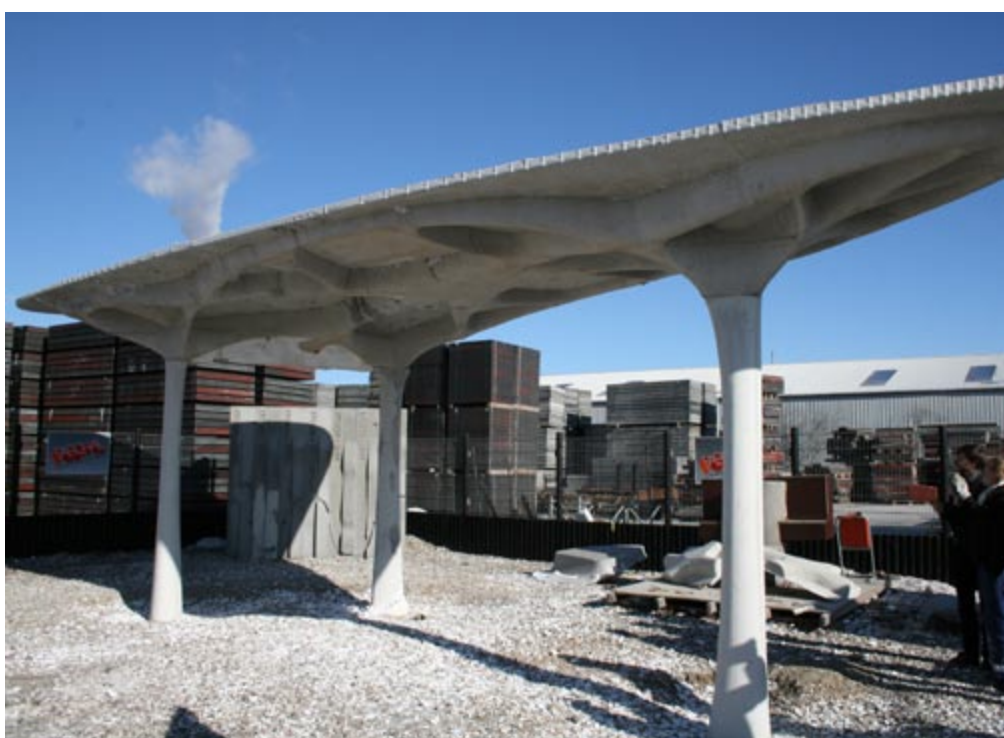
Topologioptimeret betonkonstruktion Parterne i projektet Unikabeton (DK) (Glostrup) - DK - 2009
