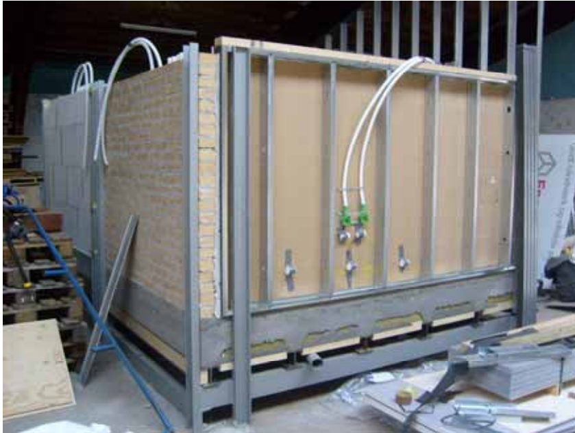
Figur 15. Sensorernas placering i en reglad vägg
