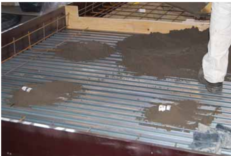
Figur 8. Noderna under ingjutning.
