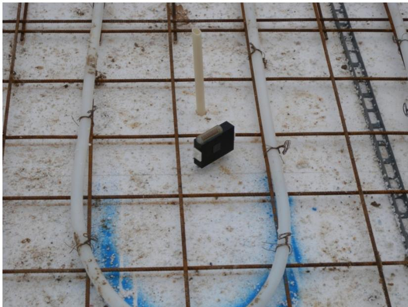
*Sensor før indstøbning i betongulv i EnergyFlexHouse projektet.*
