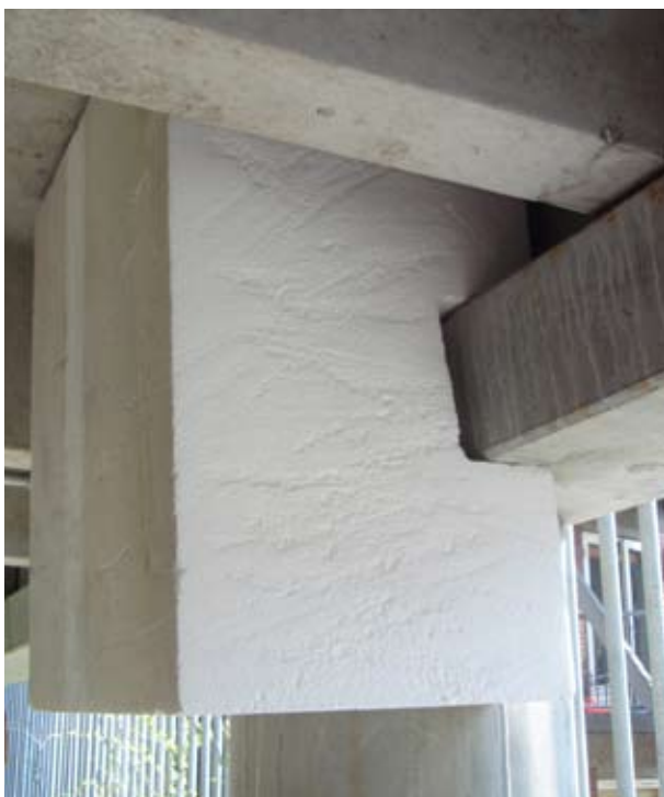
Digitalt fremstillet specialforskalling til at løse en kompliceret søjle-bjælke detalje i forbindelse med et parkeringshus på Åboulevarden.
