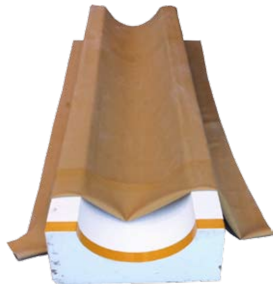
Eksempel på specialforskalling. I dette tilfælde ville søjlens ovale geometri være vanskelig at gengive i en håndværksbygget forskalling – men den gengives nemt og hurtigt via digitalt fremstillet forskalling. Der blev endvidere anvendt en gummimembran i formen for at opnå en helt glat overflade på betonen.
