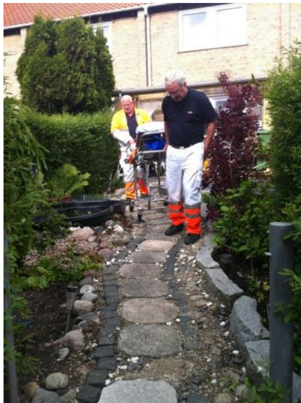
Ujævn overflade på sti ved privat bolig.
