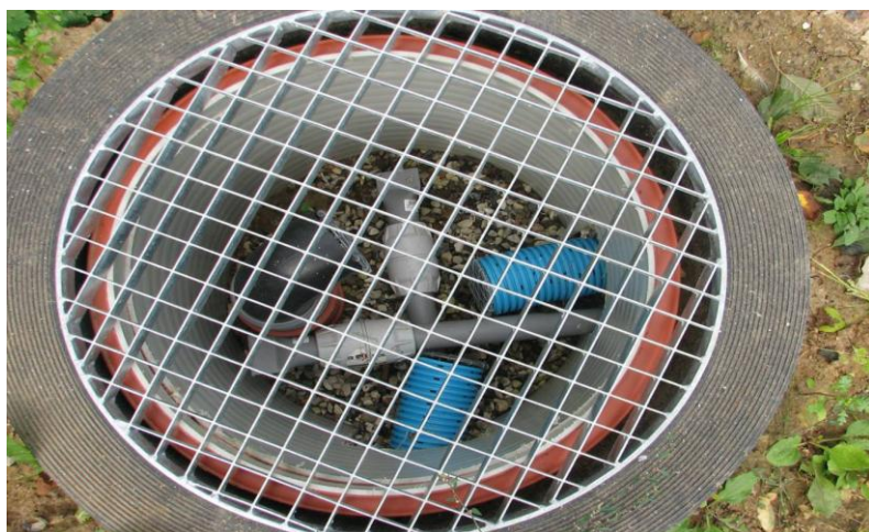
Figur 5.7 Eksempel på udluftningsbrønd i et lille nedsivningsanlæg. Der er to blå drænslinger, der udlufter fordelerlaget. Sivedrænene er afsluttet med trækfast afpropning, der kan fjernes, når drænene skal spules igennem
