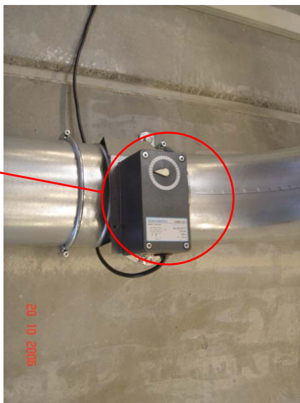
Figur 6.5. Afspærringsspjæld ved punktudsug
