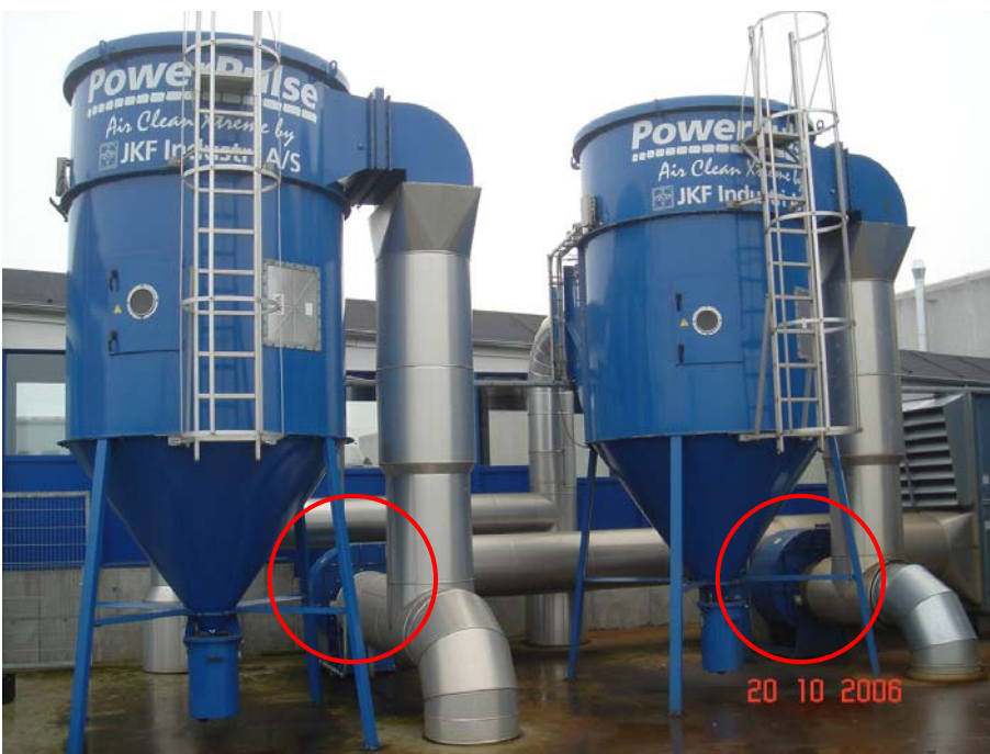
Figur 6.3. På billedet ses de to udsugningsventilatorer (røde cirkler) og de to cyklonfiltre.
