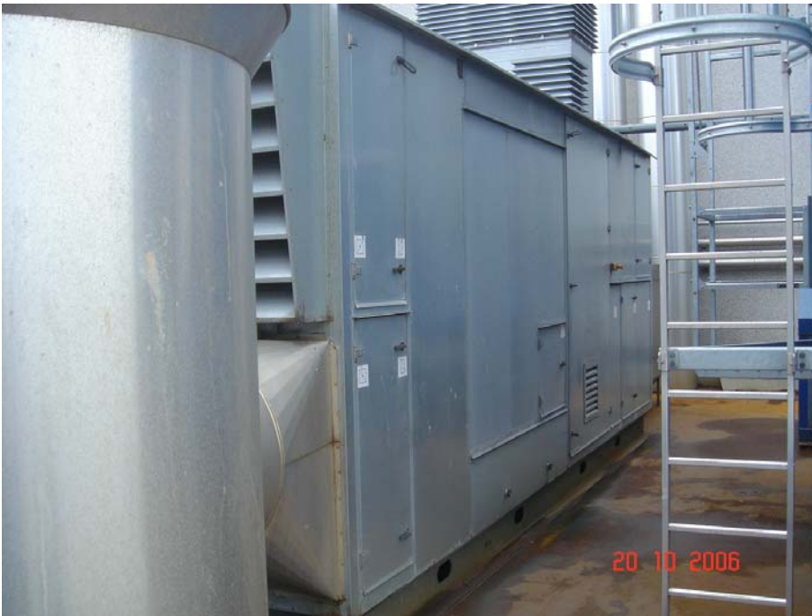
Figur 6.2. Aggregat med indblæsningsventilator, krydsvarmeveksler og eftervarmevlade.
