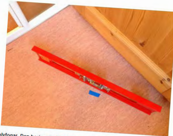
Bild 3. Lokalt bakfall vid dörr
