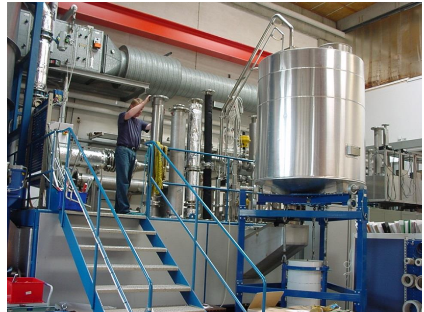
Vejetank til afvejning af op til 100 kg vand anvendes ifm. flowmåling
