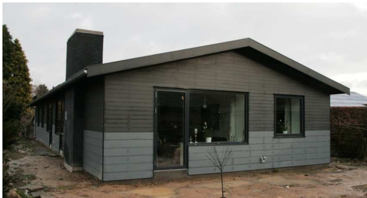
Huset på Udbakken efter energirenoeringen
