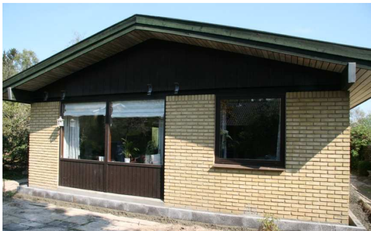
Huset på Udbakken før energirenoveringen
