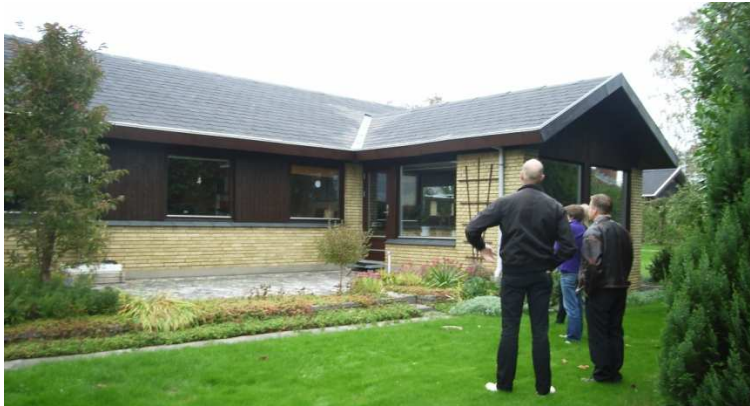
Huset på Sommerbuen før energirenoeringen
