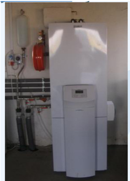
Figur 8 Typisk VP unit med indbygget varmtvandsbeholder
