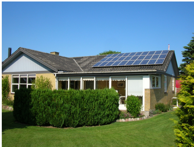
Figur 17 Typisk husstands anlæg af krystallinske standardmoduler monteret ovenpå eksisterende tag.
