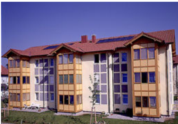
Figur 4 Efterisoleret bolig med transparent isolering i de mørke felter
