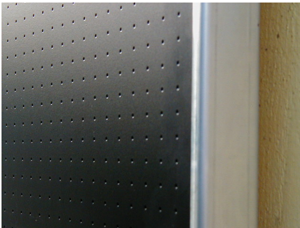
Figur 5 Produktet SolarWall er en luftsofanger, som samtidig isolerer den facade den er monteret på. Princippet bruges i den meget udbredte ”sommerhussolfanger” fra Aidt Miljø for automatisk indblæsning af friskluft. SolarVentien isolerer dog ikke, den er typisk hæftet op på et par beslag
