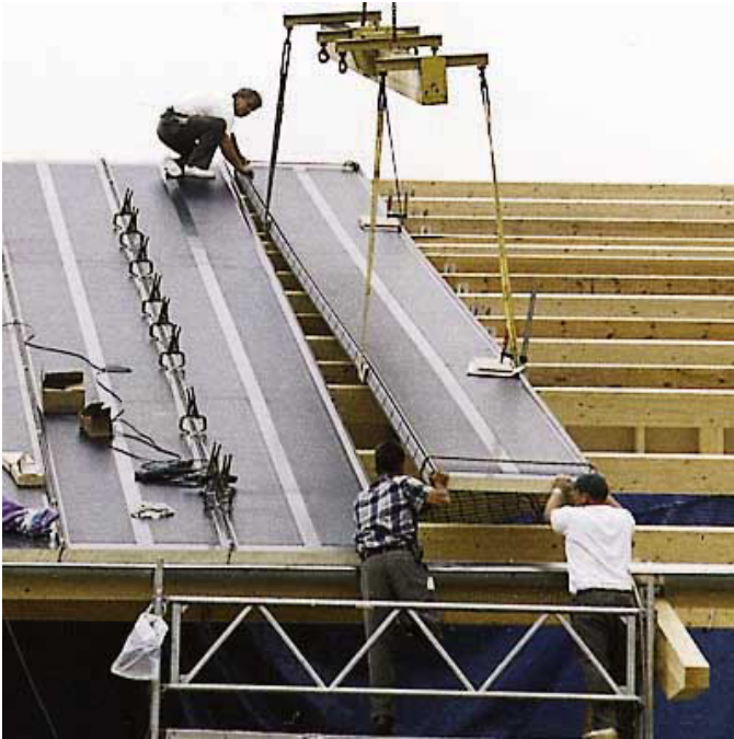
Figur 2 Montage af 17 m tagelementer fra Thyssen (Tyndfilm)
