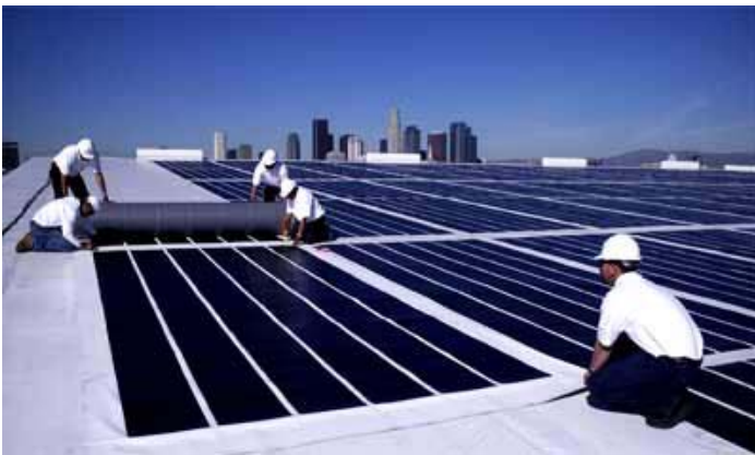
Figur 3 SmartRoof tyndfilm på rulle til store arealer
