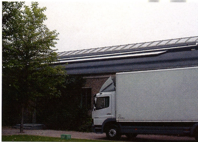
På Arkitektsskolen på Holmen er solcellerne blevet indarbejdet i den eksisterende arkitektur.
