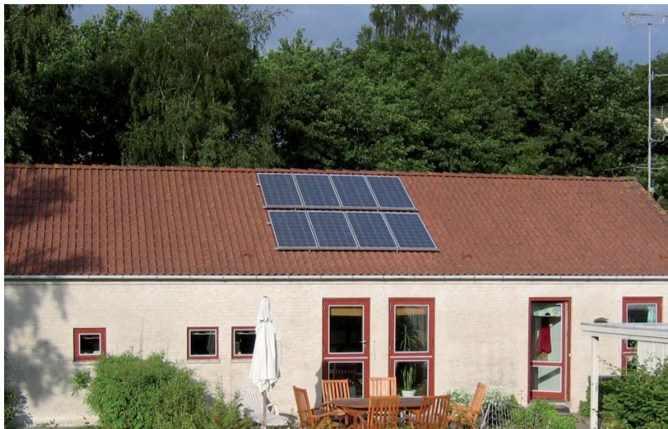
Billede 1 Traditionelt add-on anlæg oven på tagsten.
