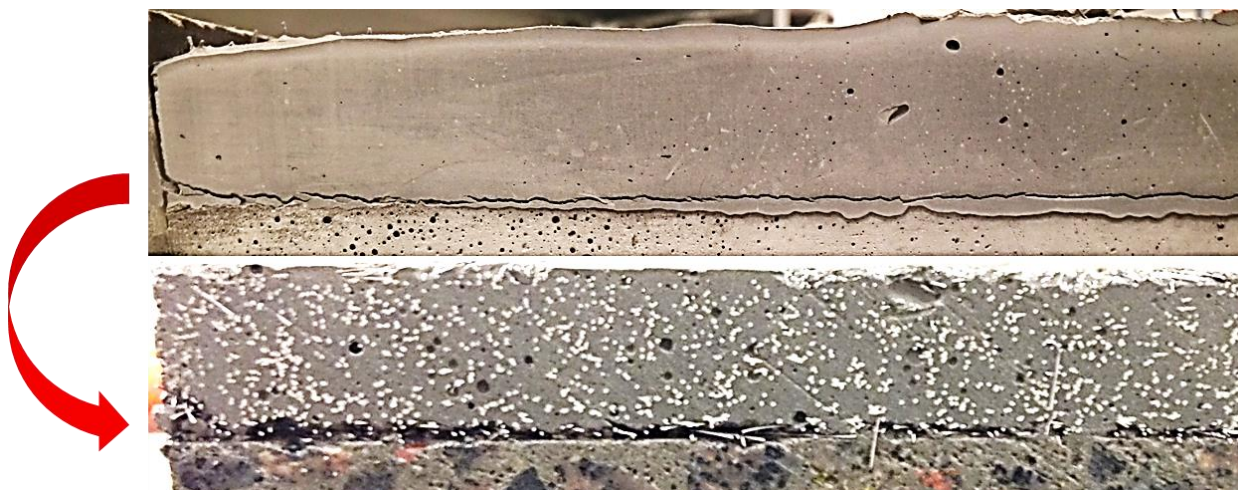
Figur 1 – Eksempel på kraftig delaminering mellem UHPFRC-slidlag (øverst) og beton (nederst). Rød pil markerer zoom af lodret snit omkring delaminering [2].
