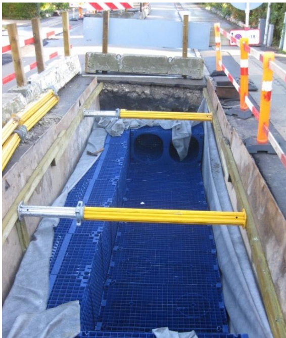
Figur 5: Regnbed nr. 1 på Lindevang under anlægsfasen ved udlægning af plastkassetter.
