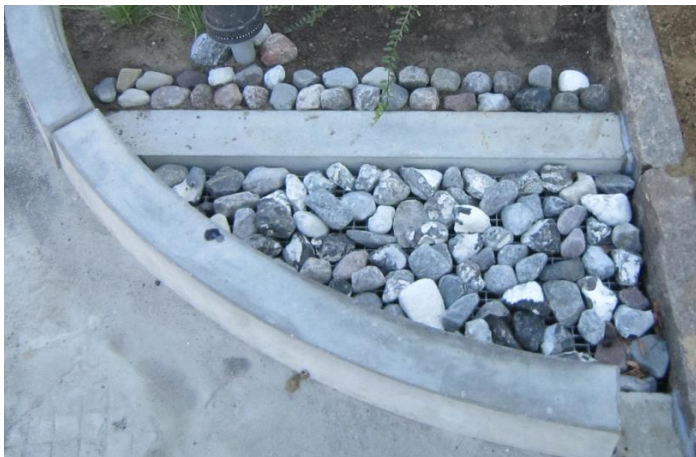
Figur 6: Forbassinet på Møllebakken.
