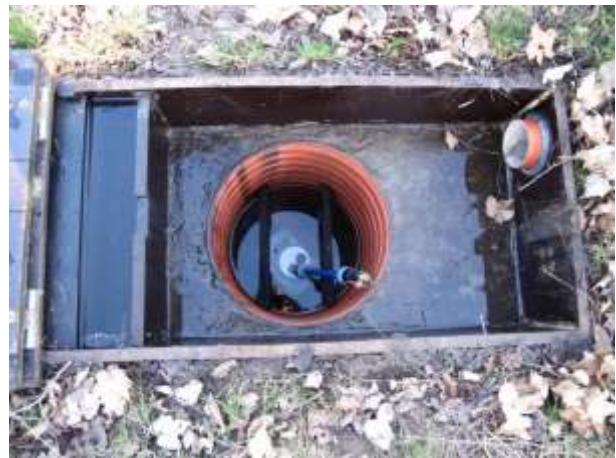
Figur 20: Forhøjet afløb fra forfilter kote 7,66, der sikrer at alle strømningslag i DPF er vandførende, og bunddræn fra forfilter Ø12, som afdræner forfilteret på ca. 12 timer. På fotoet er bunddrænet aktivt.
