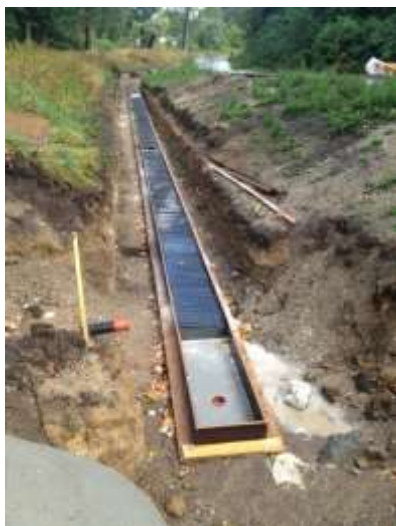
Figur 21: Hovedfilter under opbygning. DPF-plader er lagt i enkeltvis og klikket sammen; et lag af gangen. Der er manuelt lagt 10 mm kalk i DPF-plader mellem tværribber, hvorefter næste lag plader er lagt ovenpå. I alt 10 lag plader som danner 9 dobbeltporøse lag. Mellem øverste DPF-plade og låget er lagt et lag kalk for at minimere risiko for bypass.
