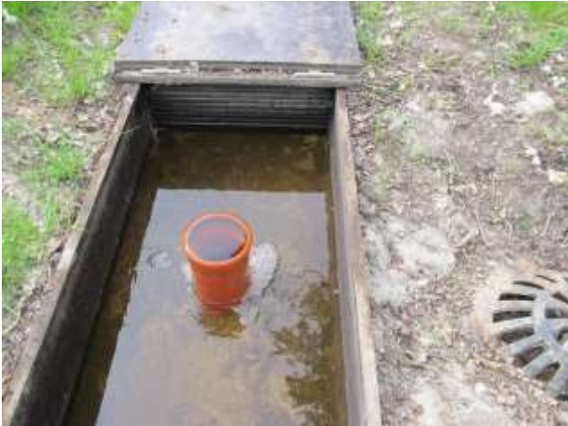
Figur 19: Forfilterets udløbskammer. I midten ses brønd Ø425 med fyldt passiv-prøvetager. I venstre side ses DPF-kassette og forhøjet afløb fra filteret i kote 7,66 og drænafløb i kote 7,45. Det forhøjede afløb sikrer, at forfilteret bliver fyldt inden afstrømning med 0,5 L/s begynder. Rør Ø110 i højre side er til udluftning af hovedfilter.
