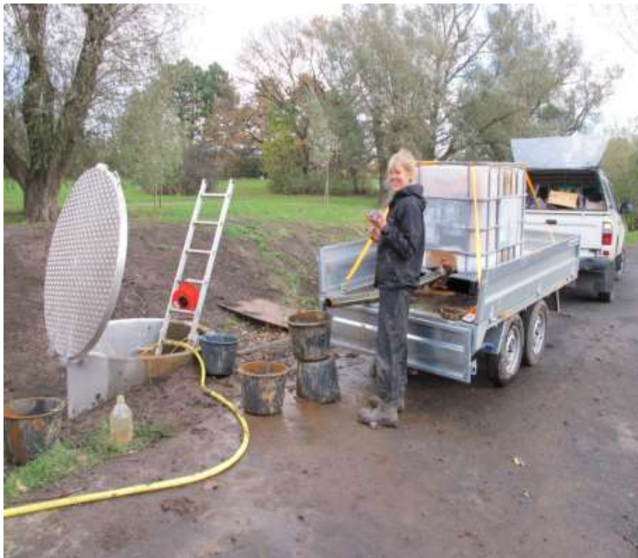
Figur 6: Indlejring af okker i DPF-Krogebjerg. Hovedfilteret fyldes med vand og vandet recirkuleres modsat almindelig retning med en pumpe i hovedfilterets indløb (gul slange) til udløbsbrønden. Okkerslam løber fra tank på trailer til spand, der tømmes ud i udløbsbrønd, hvorfra det følger vandstrømmen ind i filteret gennem filterets udløb. Efter al okkerslam er hældt i fortsættes med at recirkulere over hovedfilteret indtil recirkuleringsvandet er nogenlunde klart.
