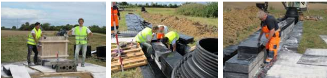
Figur 31. Montage af DPF-kassetter Venstre: Fyldning af DPF-kassetter med kalk i felten. Midt: DPF-kassette lægges i anlægget. Højre: Zigzag opbygning er næsten færdig (PE-membraner blev efterfølgende lagt under forfilter og svejst på siden af hovedfilter).
