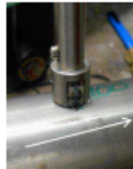
capteur étalon tangent à la canalisation :
