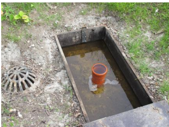
Figur 2. Forhøjet indløb i form af Ø110 rør blev monteret 10/6 for at forhindre tilbageløb af vand fra DPF-forfilter, når pumpe i BR03 stopper.
