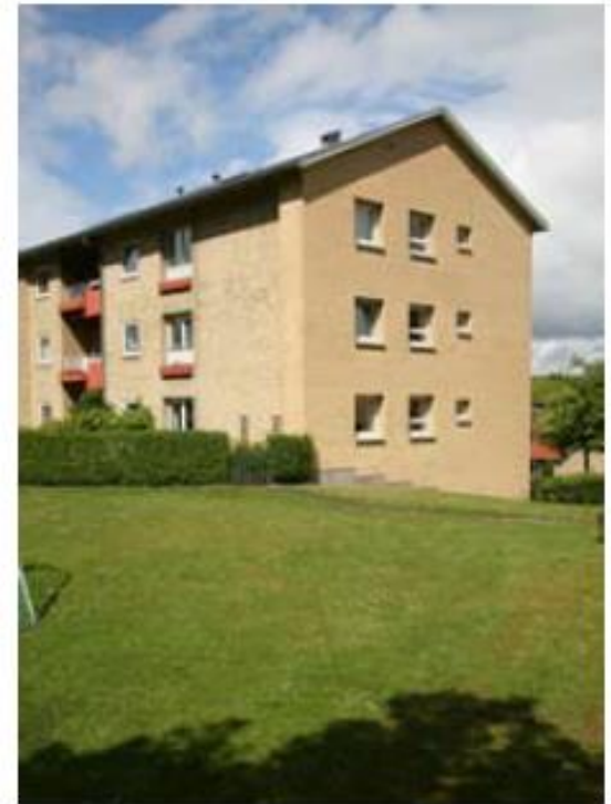
Massive gavlmurer kræver efterisolering. Gavl- mur skalmuret med samme stentype som den oprindelige.
